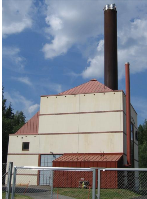
Kuva 33. Pitkälahden lämpökeskus, tukiasemapistettä.
