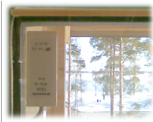
Kuva 15. Jokaiseen ikkunalämmitysryhmään asennettiin yksi ikkuna-anturi.
