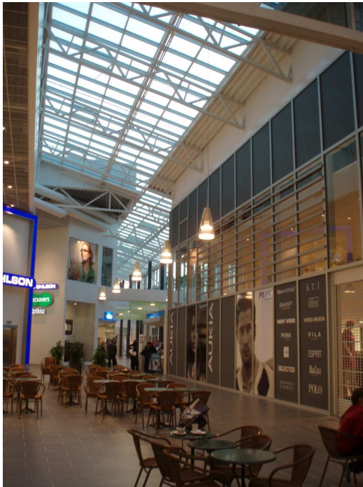
KUVA 2. Alumiinirakenteinen valokatto ja lasiseinä. (Stroitel Oy 2008)
