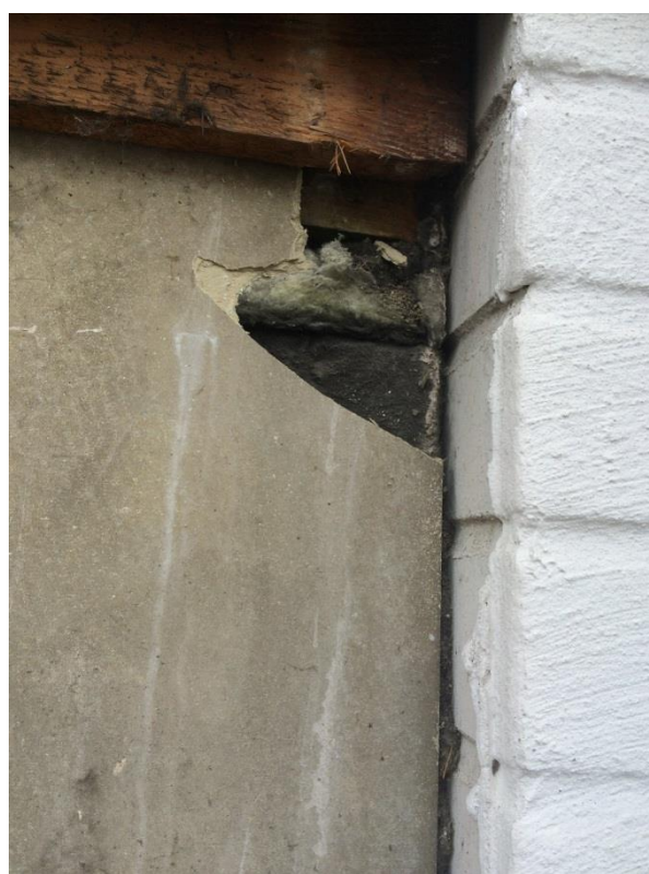
Kuva 7 US1 rakenneavaus (Marttinen 2016-09-13)
