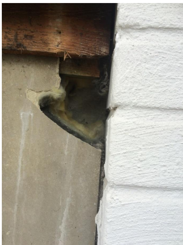
Kuva 6 US1 rakenneavaus (Marttinen 2016-09-13)
