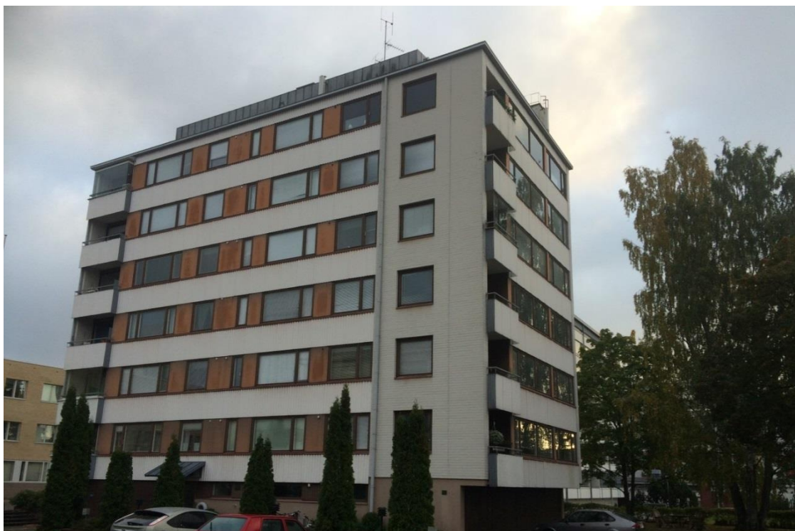
Kuva 3 Länsipuoleinen julkisivu (Marttinen 2016-09-13)
