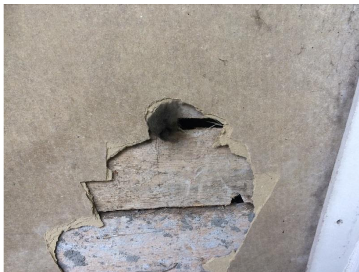
Kuva 5 US3 rakenneavaus (Marttinen 2016-09-13)
