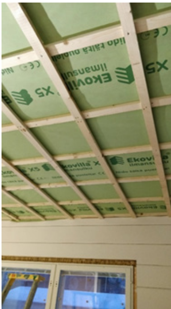
Kuva 78. Ilmansulku ja koolausrimat asennettuna (Hyvärilä 2017)
