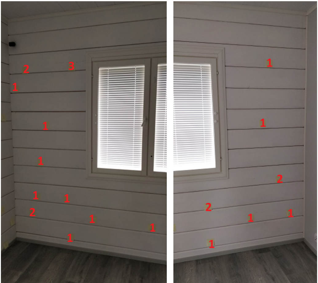
Kuva 120. Ensimmäisen makuuhuoneen eteläpuoleinen seinä (Hyvärilä 2018)
