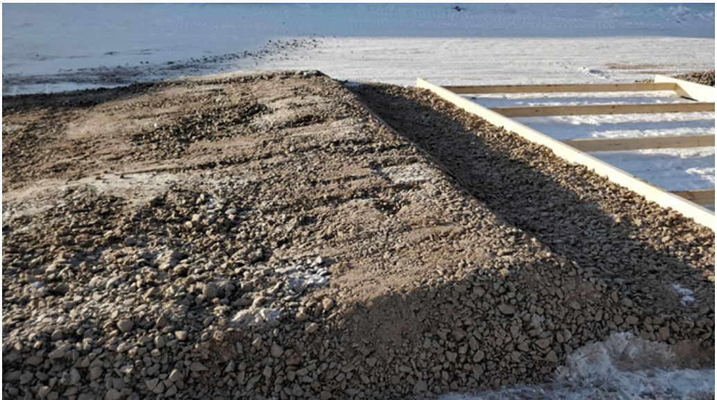
Kuva 37. Jäädystystä vaille valmis perustus (Hyvärilä 2018)
