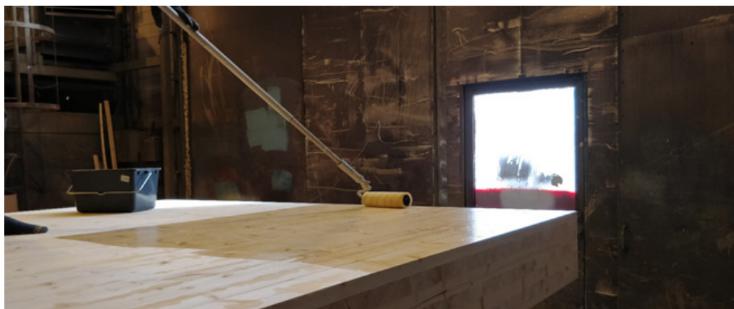
Kuva 48. Teknopur Sealer 100-00 –pohjustusaineen levitys (Hyvärilä 2018)
