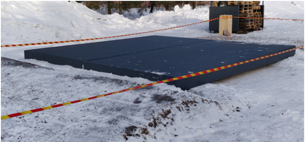
Kuva 50. CLT-elementit asennettuna paikoilleen (Hyvärilä 2018)
