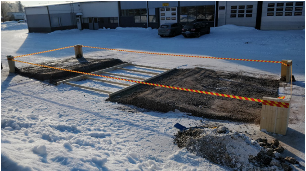
Kuva 38. Jäädystä vaille valmis perustus ja silta-alue eristetty huomionauhalla (Hyvärilä 2018)
