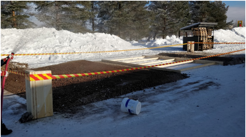
Kuva 39. Siltarakenteen jäädytys (Hyvärilä 2018)
