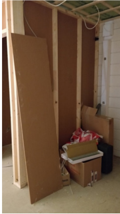
Kuva 77. Väliseinien valmistumista. Väliseinän kohdalla seinällä näkyy pisteen 1 sensori. (Hyvärilä 2017)
