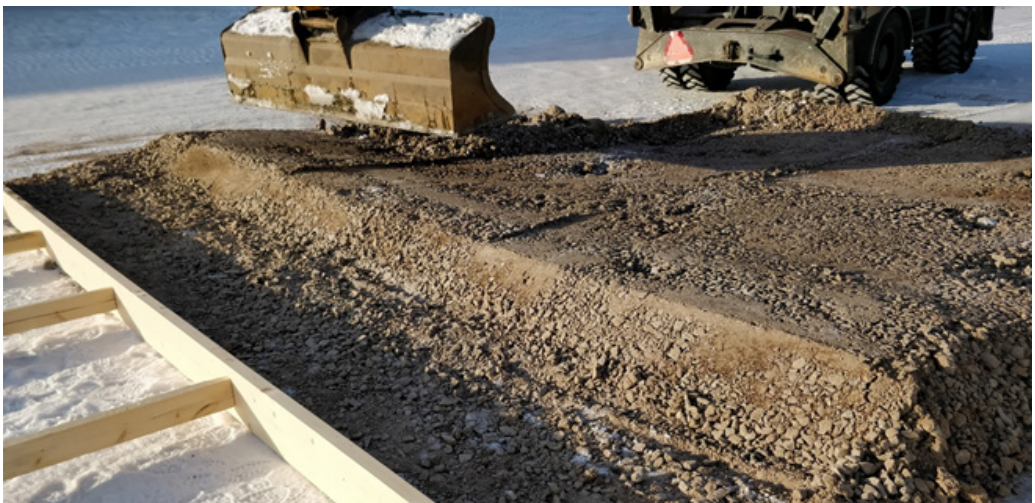
Kuva 35. Perustukset muotoiltiin kaivinkoneen avulla kiilamaiseksi (Hyvärilä 2018)
