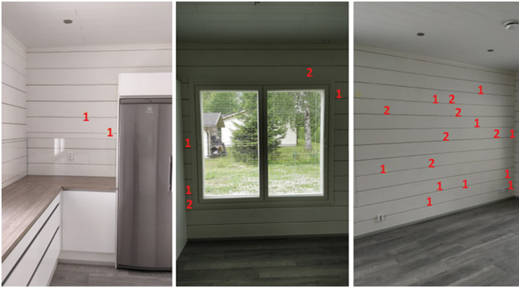
Kuva 125. Keittiö-olohuoneen lännenpuoleinen seinä (Hyvärilä 2018)
