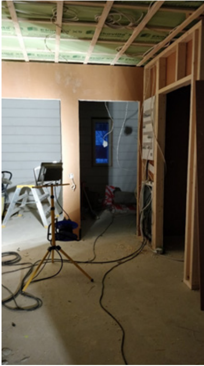
Kuva 76. Väliseinien valmistumista (Hyvärilä 2017)
