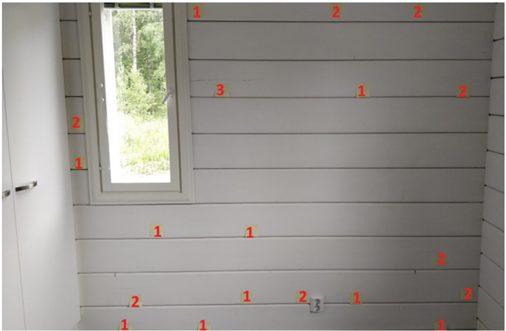
Kuva 121. Ensimmäisen makuuhuoneen idänpuoleinen seinä (Hyvärilä 2018)
