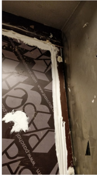
Kuva 12. Sovitteen saumat tiivistettynä (Hyvärilä 2017)
