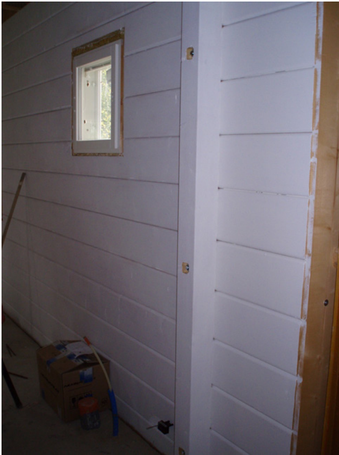
Kuva 62. Seinät pintakäsiteltiin sisäpuolelta valkoisella öljymaalilla (Hyvärilä 2017)
