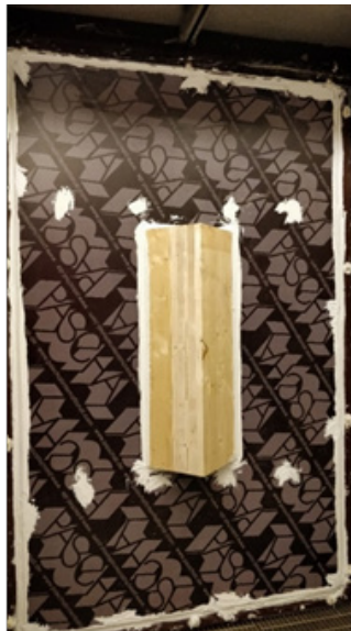
Kuva 10. Liitos asennettuna sovitteeseen (Hyvärilä 2017)
