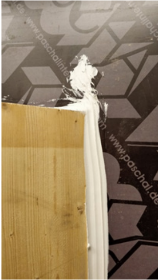
Kuva 11. Liitoksen saumat tiivistettynä (Hyvärilä 2017)
