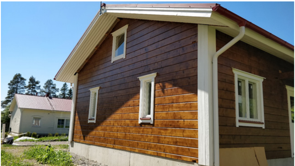
Kuva 112. Auringonsäteilyn rasitus itäseinällä (Hyvärilä 2018)
