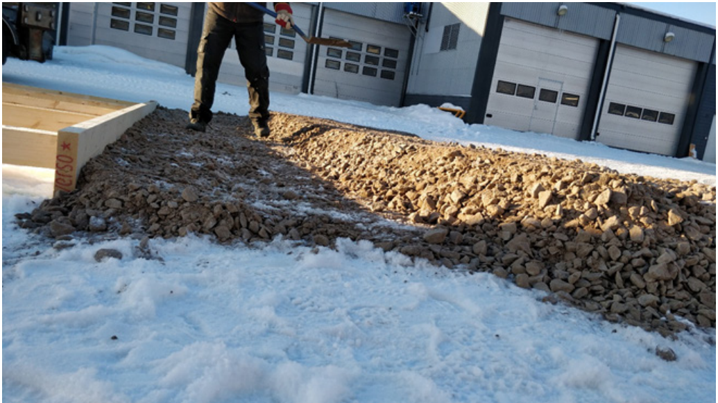
Kuva 36. Perustuksiin muotoiltiin paikka CLT-elementille (Hyvärilä 2018)
