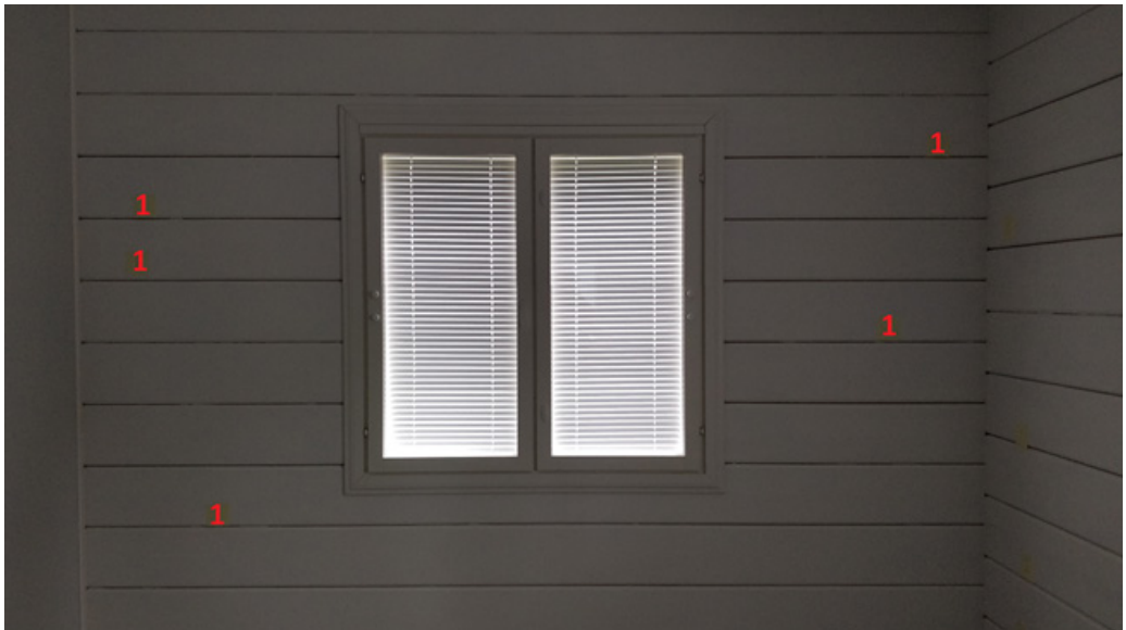
Kuva 122. Toisen makuuhuoneen pohjoispuoleinen seinä (Hyvärilä 2018)
