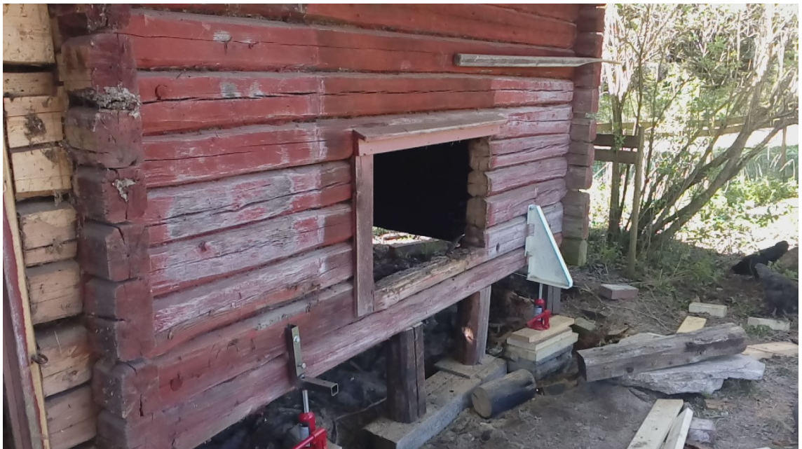
KUVA 12. Pihasauna väliaikaisesti tuettuna
