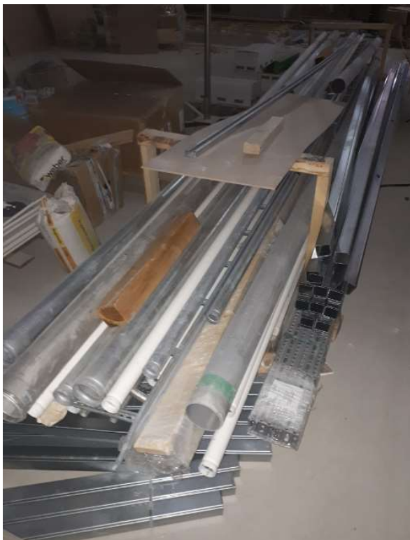
Kuvat 4: Materiaalia aulassa, siirrelty useaan otteeseen pois tieltä.
