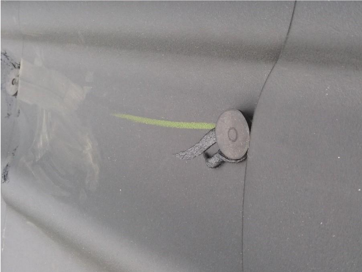
Kuvat 4-5. Paneelien paikat merkitään kattoon liidulla ja kiinnikkeet asennetaan katolle. Kiinnikkeiden päälle tuli metallikiskot. Peltikattoon kiinni tuleva ruuvi tiivistetään bitumilla. Kumipidikkeet vähentävät metallien välistä hankausta.
