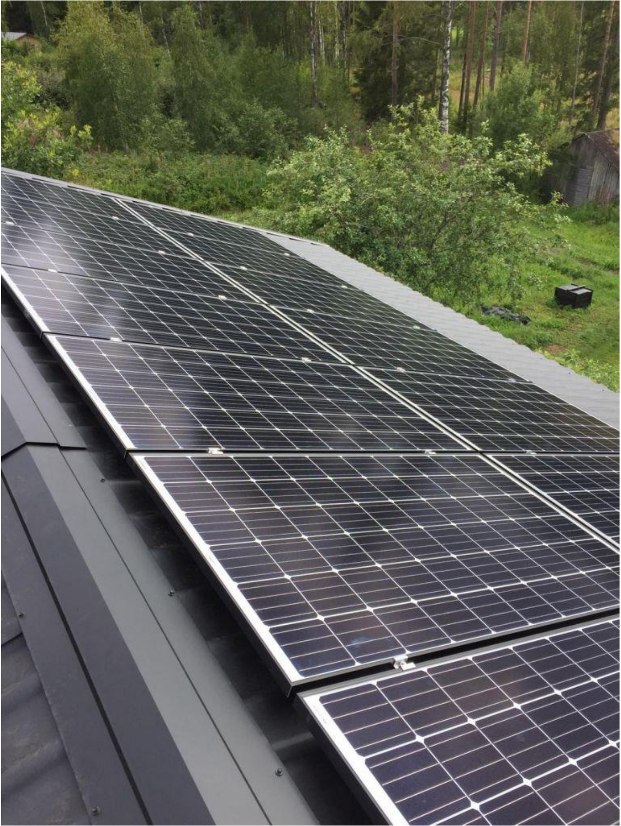
Kuva 7. Paneelit asennettiin lounaanpuoleiselle lappelle kahteen riviin.
