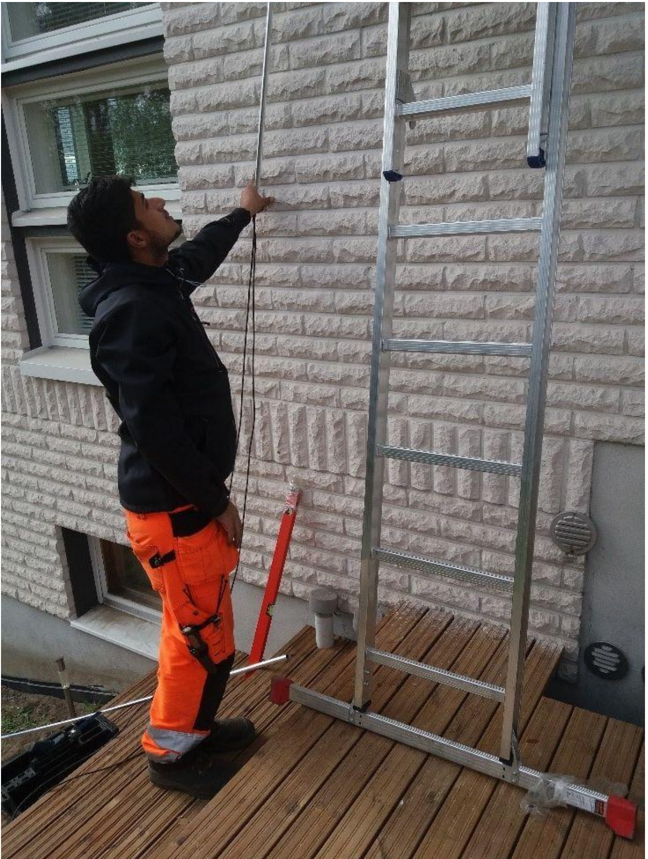
Kuva 9. Katolta tulevat kaapelit asennettiin alumiiniseen suojaputkeen pinta-asennuksena.
