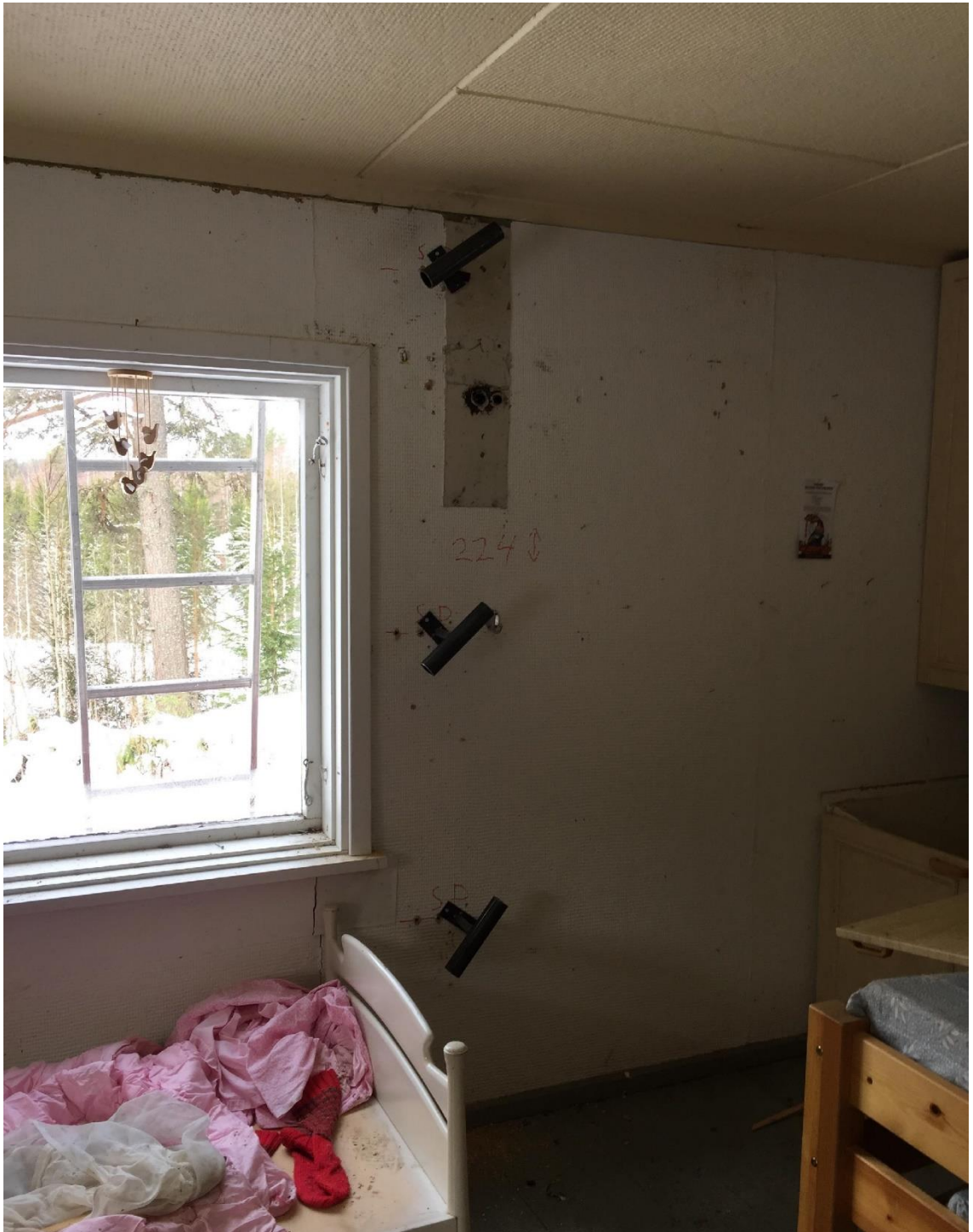
Kuva 3. Hirsipuolen termoparilangat.
