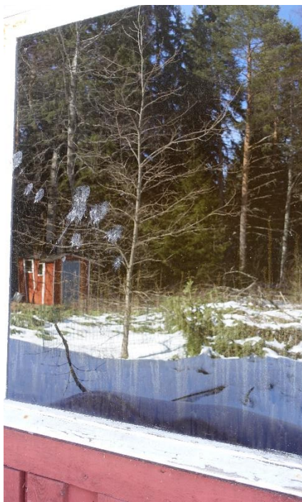
Kuva 11 Valumajäljet ikkunalasissa
