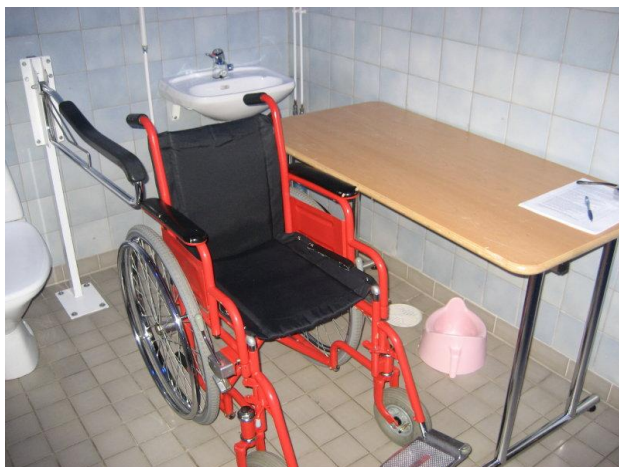
KUVIO 6. Wc-istuimen vieressä ei ole riittävästi vapaata tilaa pyörätuolille
