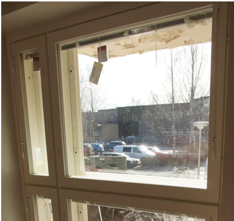
Kuva 18. Asennettu ikkuna sisältä (Liias 2019)
