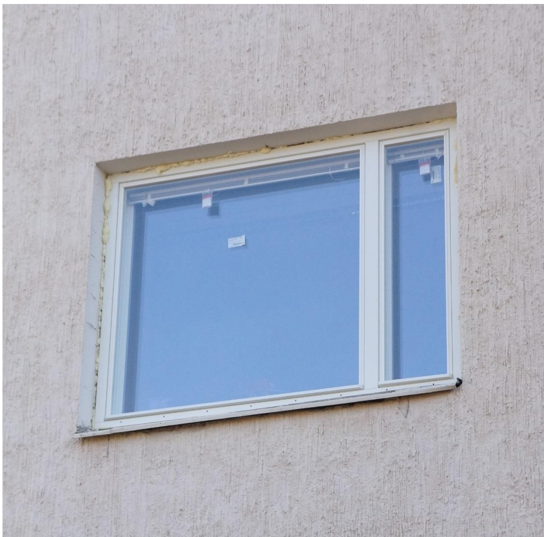
Kuva 17. Asennettu ikkuna ulkoa (Liias 2019)
