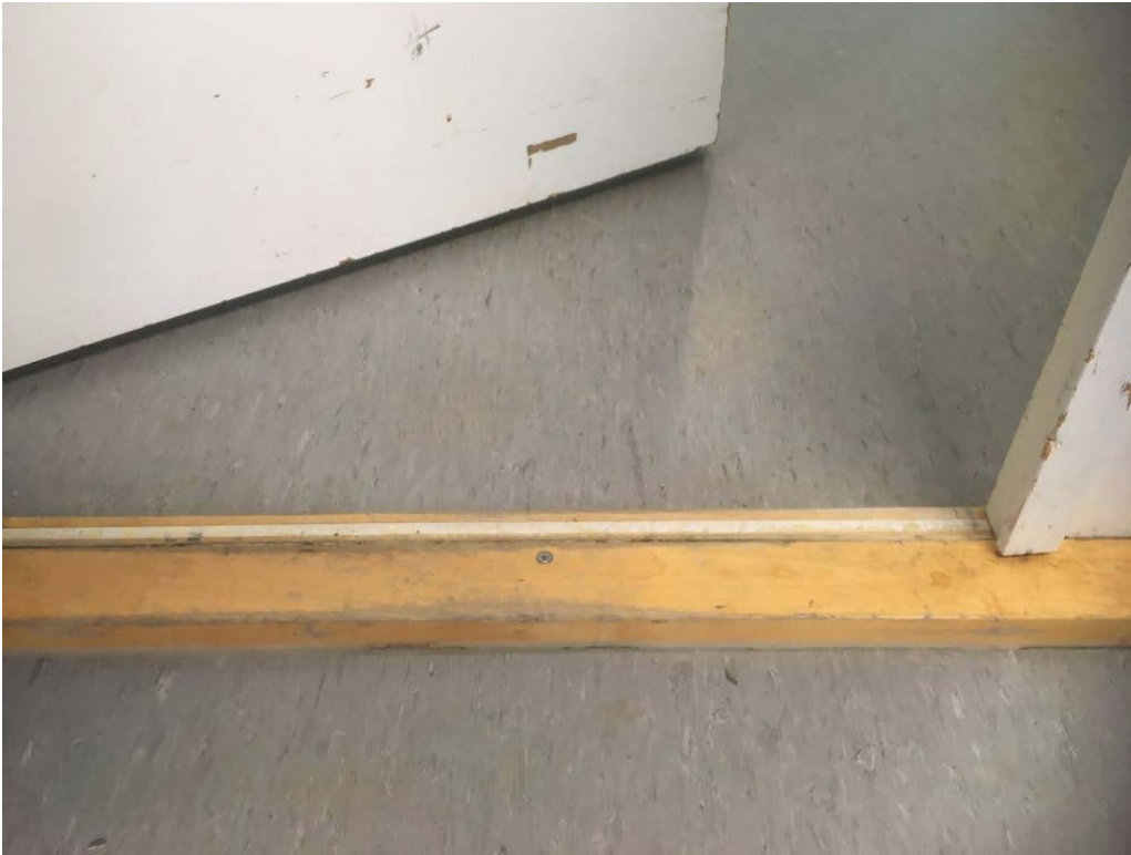
Kuva 11. Kynnykset vaikeuttavat liikkumista Frami A:ssa.
