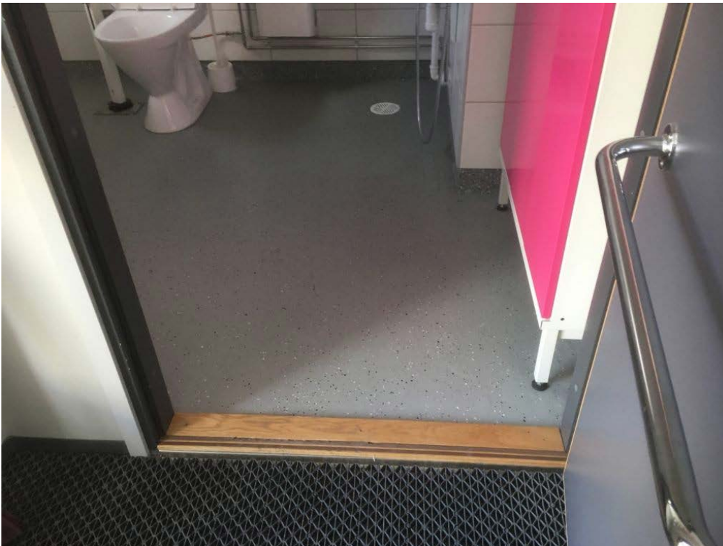
Kuva 12. Frami H:n lähes ainoa kynnyks löytyy inva-WC:stä, mutta sen korkeus on sallittu 20 mm.
