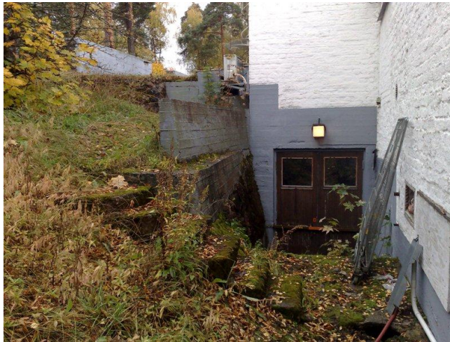
Kuva 42. Pannuhuoneen ovi ja katoksen paikka
