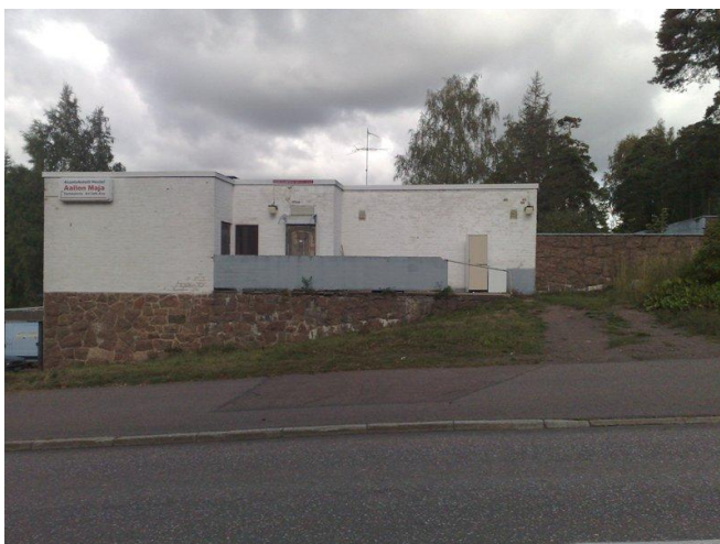
Kuva 26. Aallon Majan eteläpuolen julkisivut
