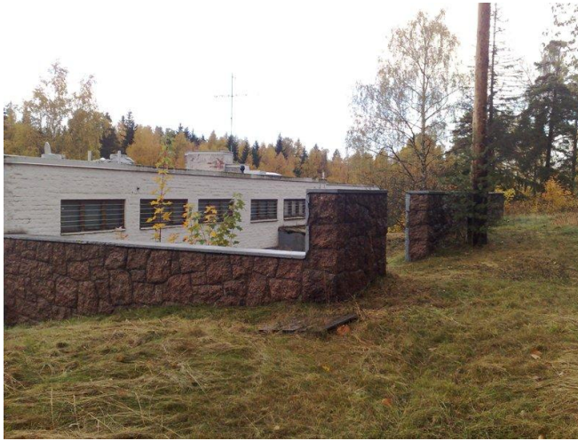
Kuva 27. Aallon Majan itäpuolen julkisivu
