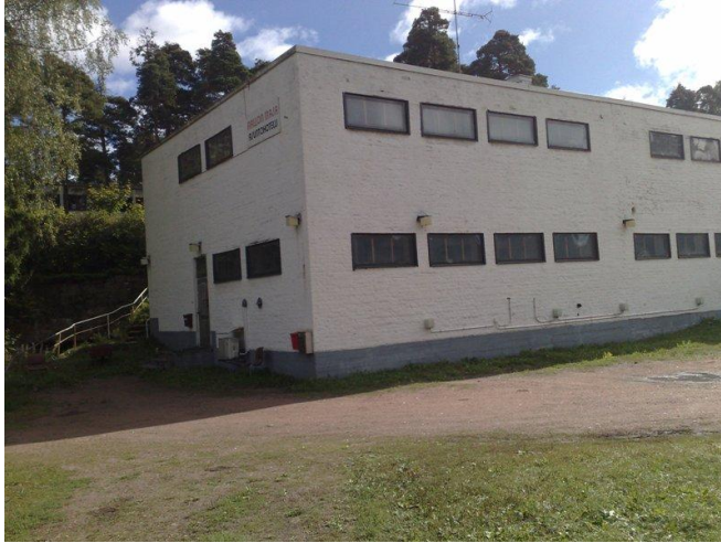
Kuva 24. Aallon Maja pohjoispuolen julkisivu
