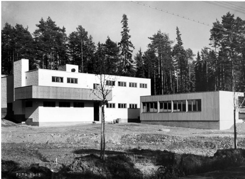
Kuva 1. Valliniemen sauna-, pesula- ja postirakennus 1938 lännenpuoleinen julkisivu. Foto Roos. Stora Enso Oyj, Sunilan tehtaan arkisto.
