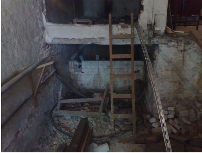
Kuva 21. Puuvaraston purettu väliseinä ja alapuolella oleva allas
