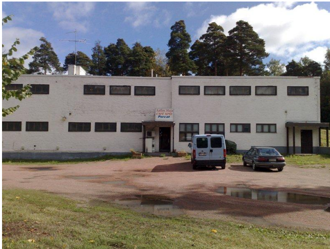
Kuva 25. Aallon Maja länsipuolen julkisivu
