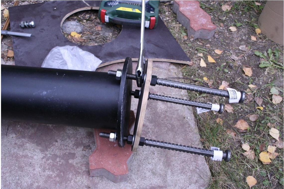
Kuva 11. Itse tehty vanerisapluuna [10]
