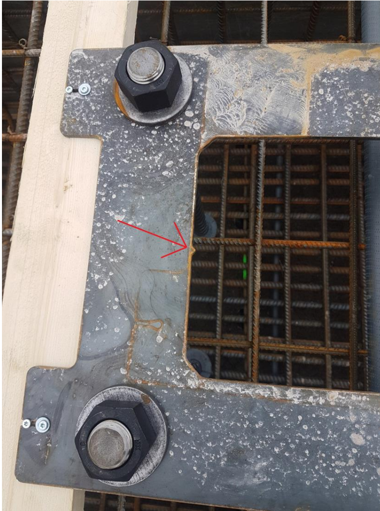
Kuva 10. Peruspulttisapluunan keskellä näkyvä kohdistusmerkki helpottaa asennustyötä. Näin ollen vastaavat kohdistusmerkit voidaan merkitä takymetrillä muottiin ja kohdistaa sapluuna linjalangan avulla paikoilleen.
