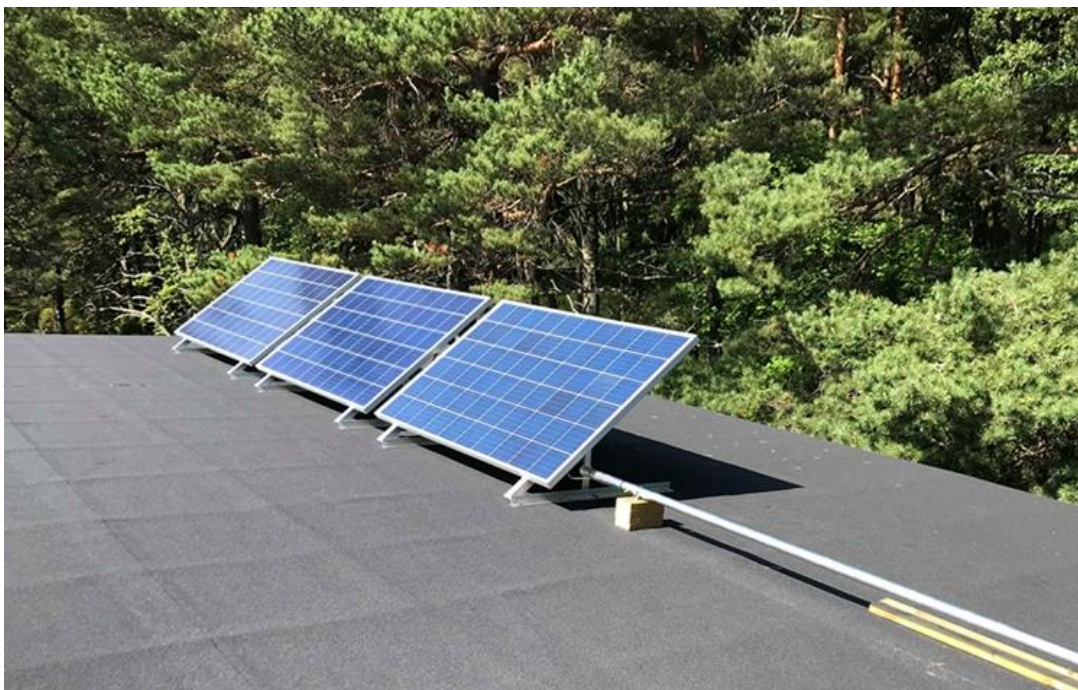
Kuva 8. Paneelit alustavasti paikoillaan.
