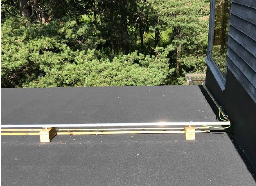
Kuva 9. Johtotie toteutettiin JAPP-putkella.
