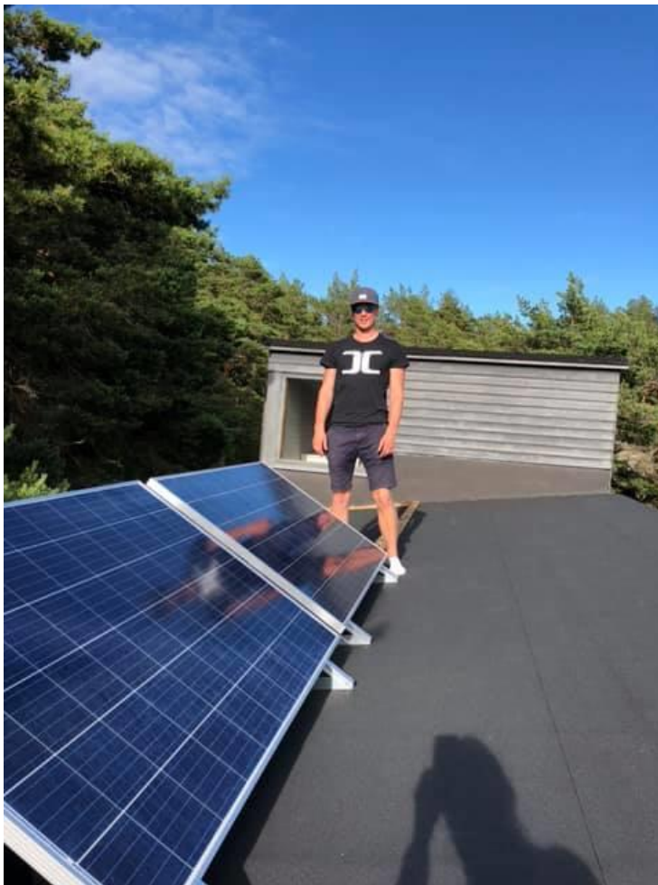
Kuva 7. Huopakatto viimeisteltiin ennen aurinkopaneelien asennusta.
