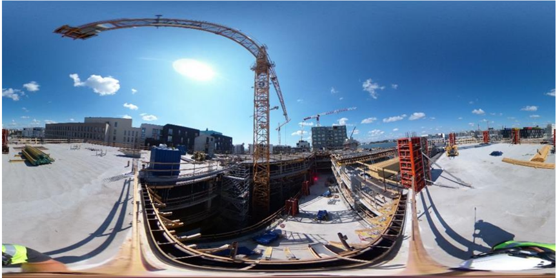
Kuva 5. Ricoh theta-V 360° kameralla otettu kuva työmaalta
