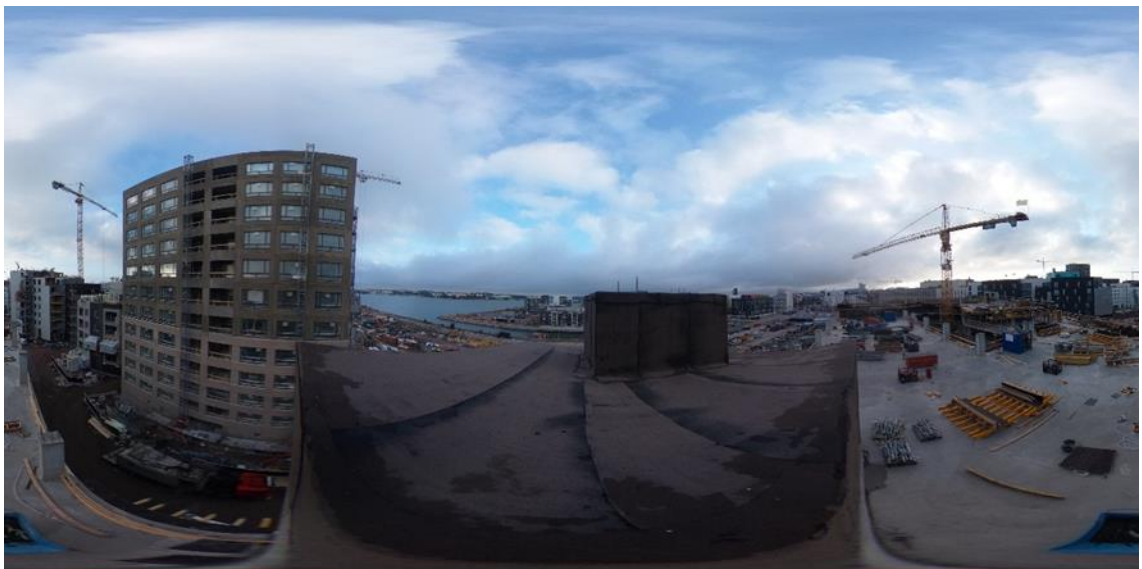
Kuva 6. Ricoh theta-V 360° kameralla otettu kuva työmaalta
