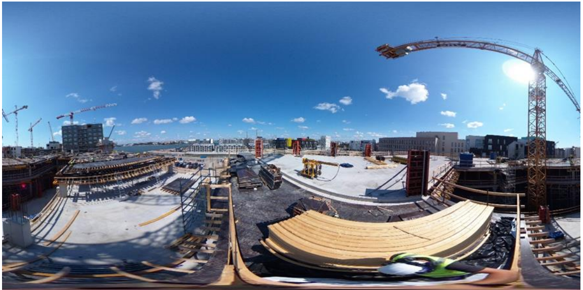
Kuva 1. Ricoh Theta V 360°-kameralla otettu kuva työmaalta
