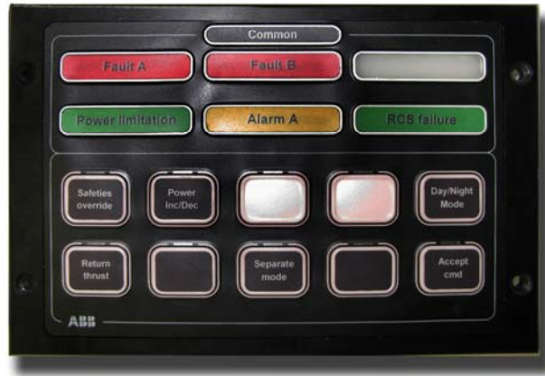
Kuva 27. Komentosillan hälytyspaneeli (ABB Oyj:n kuva-arkisto 2009).
