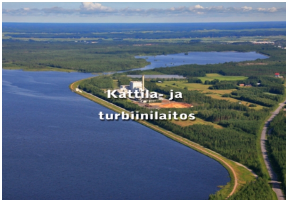
Kuva 13. Väliotsikot korjauksen jälkeen.
