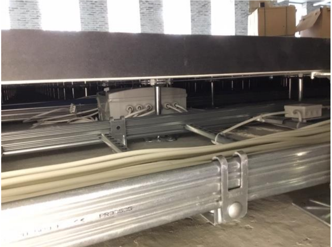
Kuva 10. Valokuva asennuslattian alapuolisesta tilasta.
