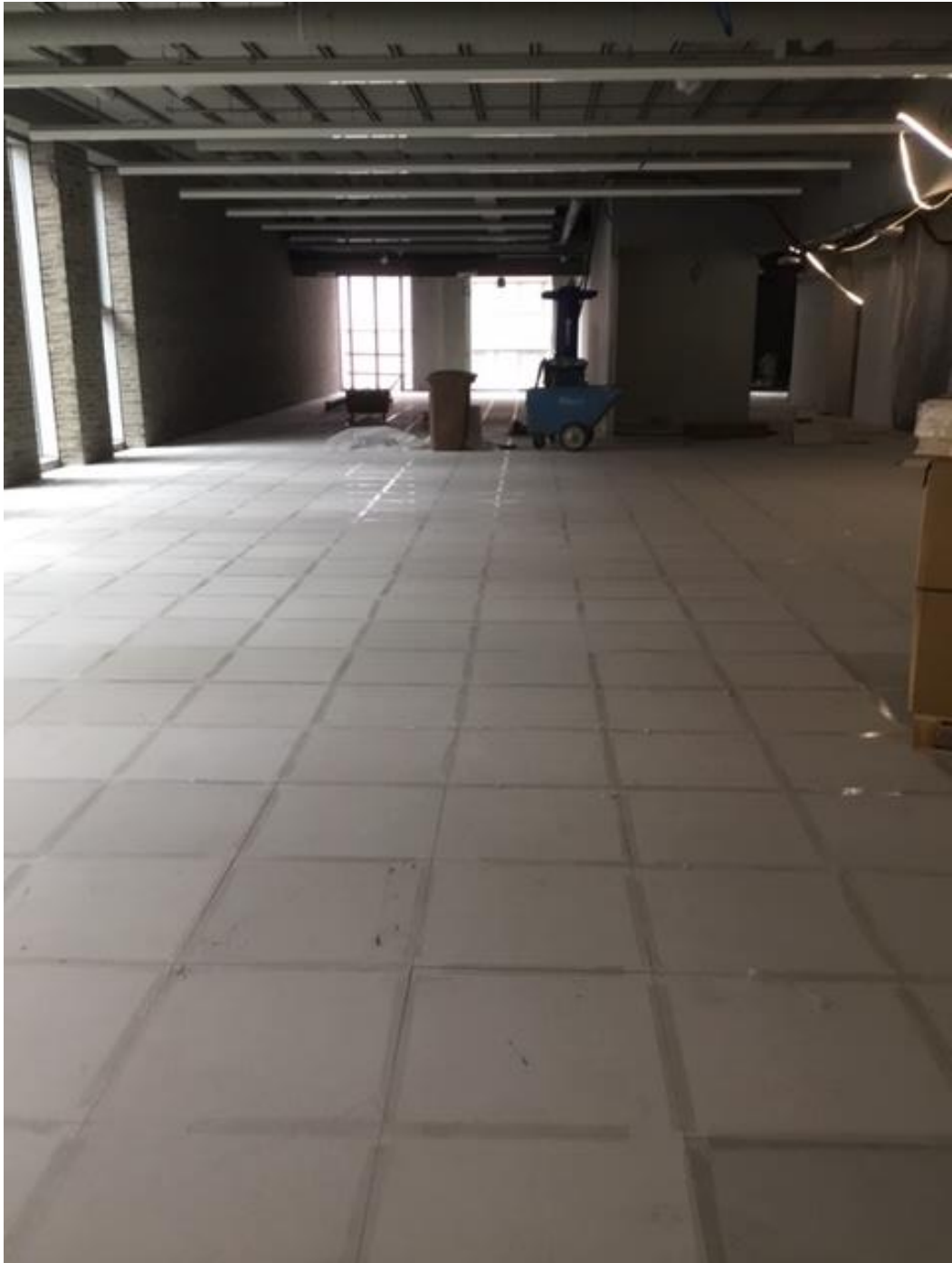
Kuva 12. Valmis asennuslattia-alue, jossa teipatut saumat
