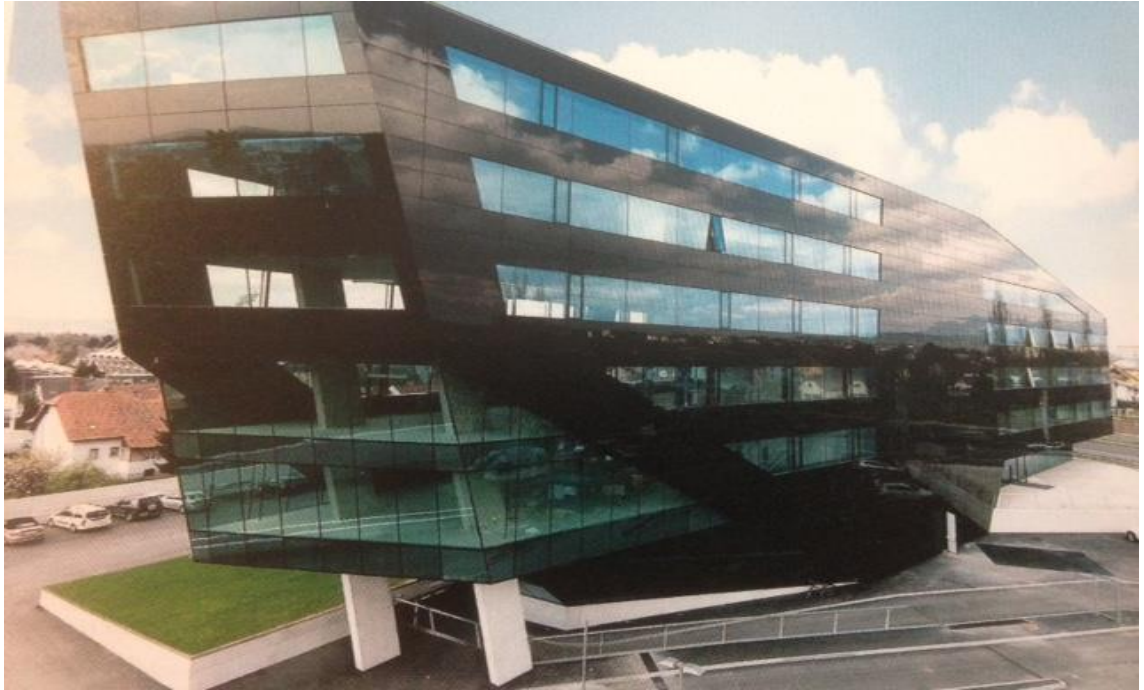
Kuva 11. Lasista toteutettu tuulettuva julkisivu [6, s. 27.]
