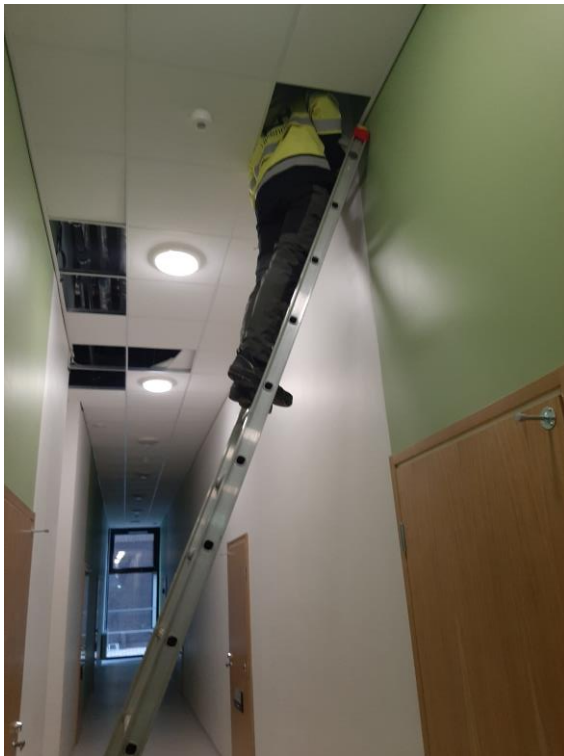
Kuva 15. Juuri valmistuneen kohteen vesimittariston lukua huoltoyhtiön huollonaloitusta varten
