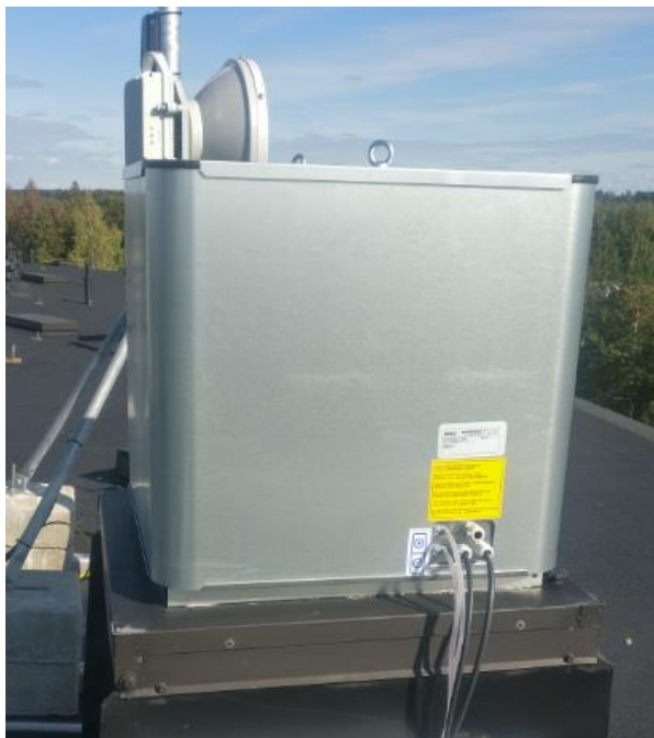
Kuva 13. PP-8 HiFEK EC-06 asennettuna paikalleen
