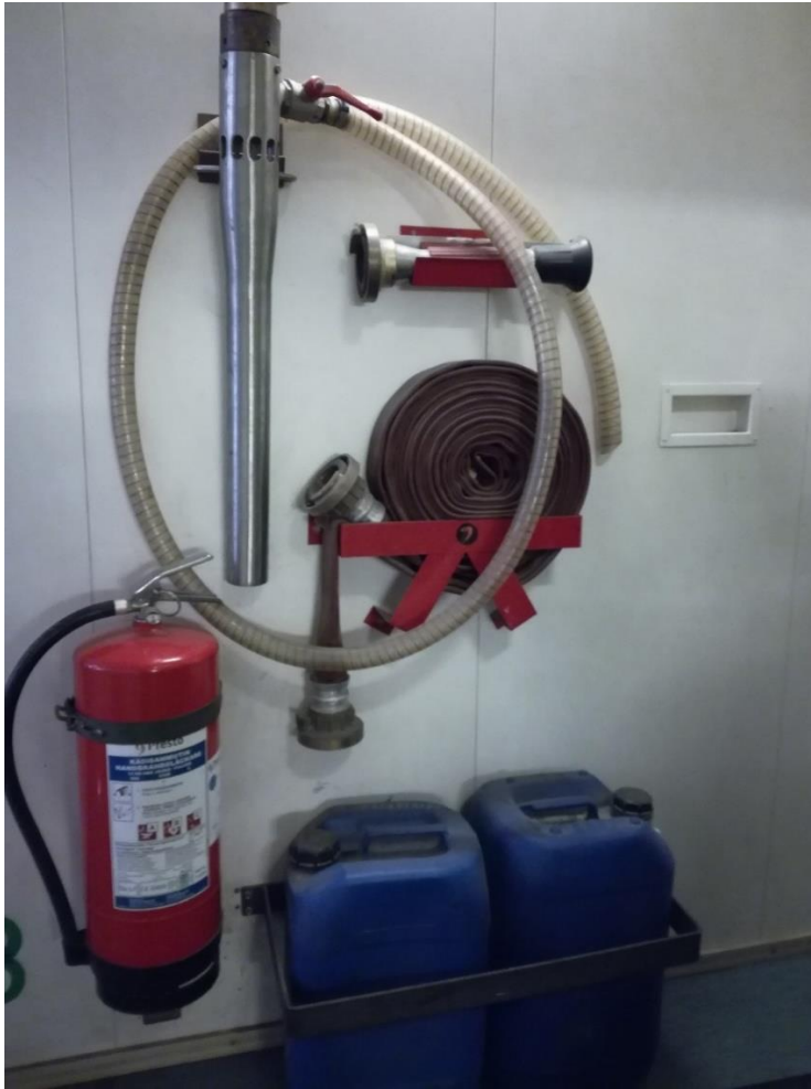
Kuva 8. Siirrettävä vaahtoyksikkö ja käsisammutin. Vaahtonesteet ovat sinisissä kanistereissa.
