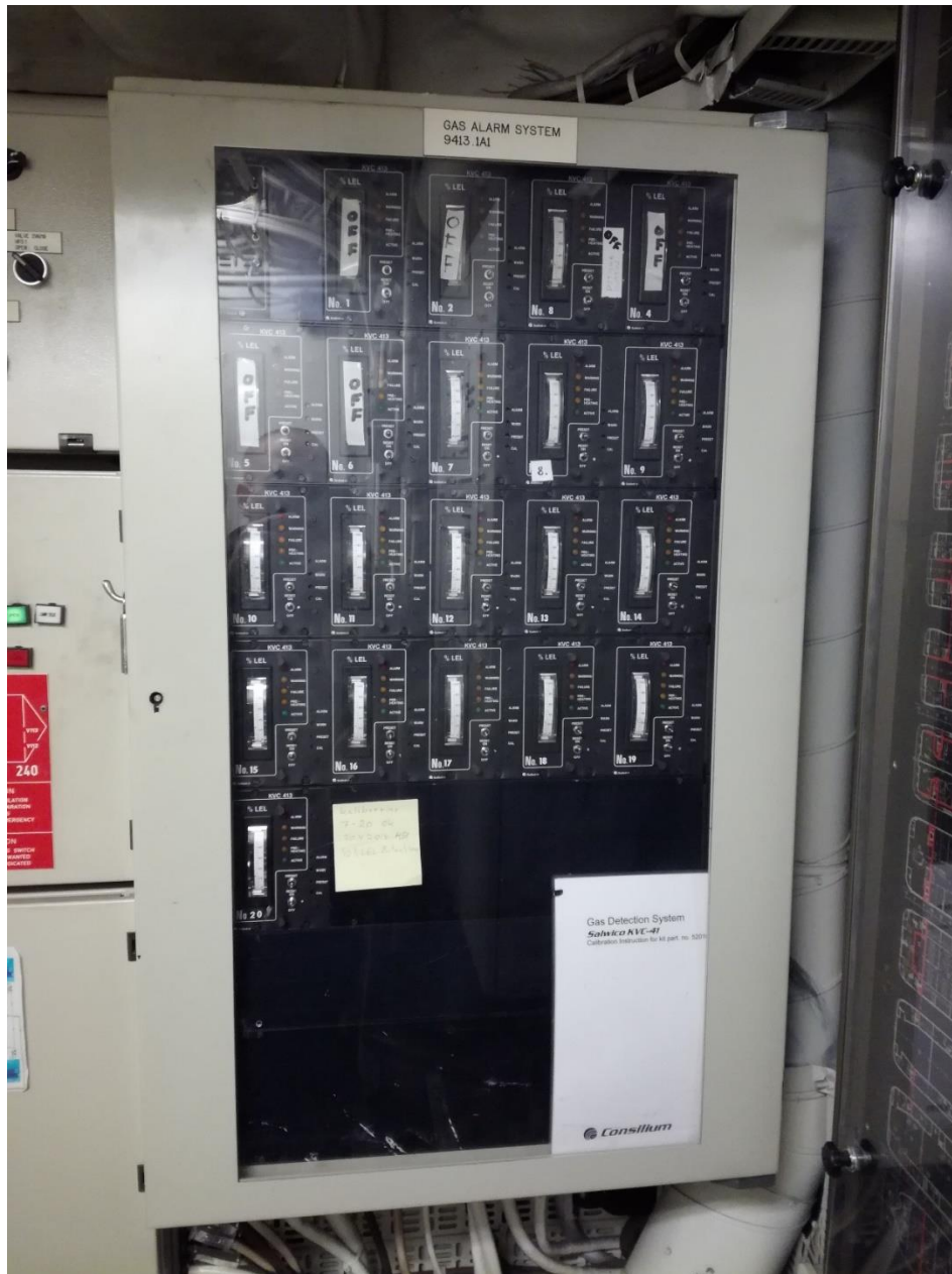
Kuva 10. Safety-huoneen kaasuilmatisintaulu.
