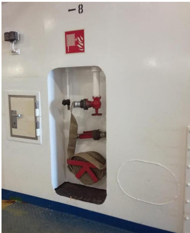
Kuva 3. Paloposti Silja Serenaden autokannella.
