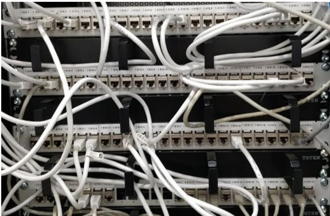
Kuva 16. RJ45-ristikytKentäpaneelita
