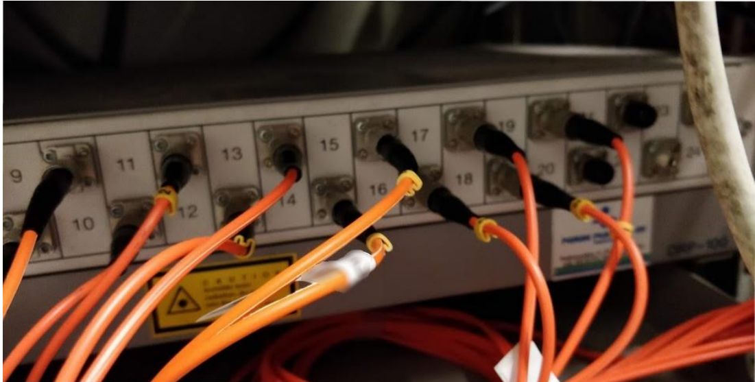
Kuva 18. Valokuitupaneeli FC-liittimillä.
