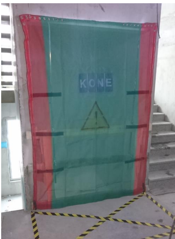
Kuva 12. Hissikuilun asennusaikainen suojaus.
