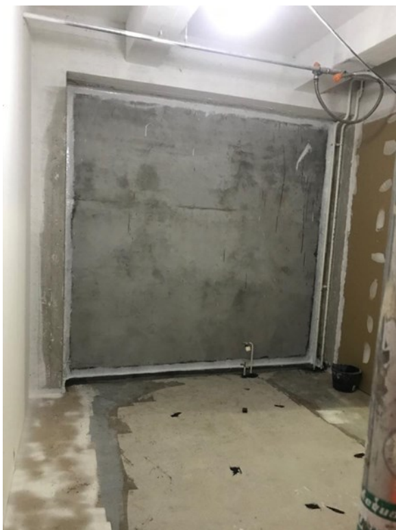
KUVA 15. Esimerkkikuva TKR -tiivistyksen dokumentaatiosta.
