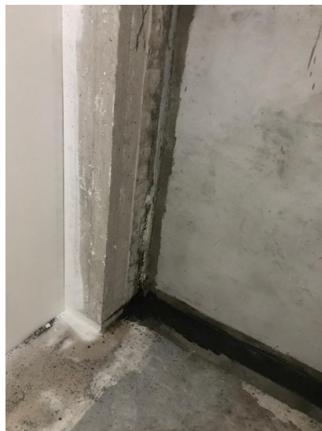
KUVAT 12 ja 13. Liittymäkohtiin asennettu ensimmäinen kerros kapselointiainetta (väritön TKR -pohjapinnoite). Kapselointikerrokset ulotettiin \geq 30 mm liittymäkohdista kumpaankin suuntaan.
