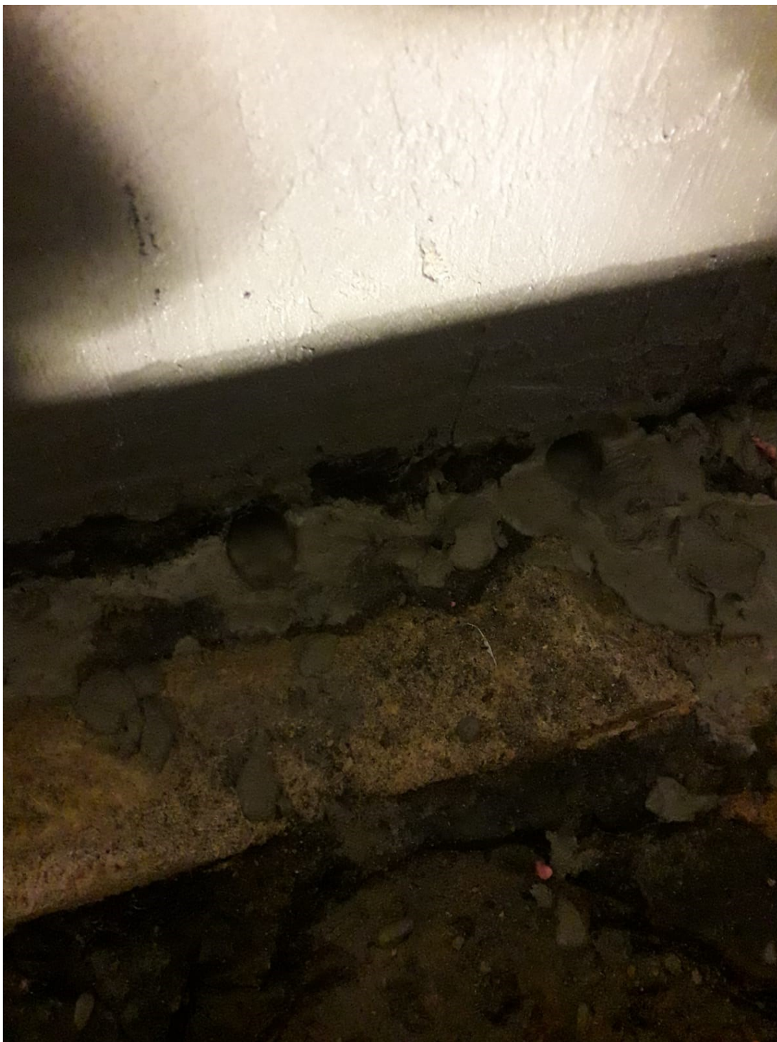
KUVA 8. Täytetty porareikä. Liuos tunkeutuu porareiän kautta betonin huokosiin estäen veden kapillaarisen nousun.
