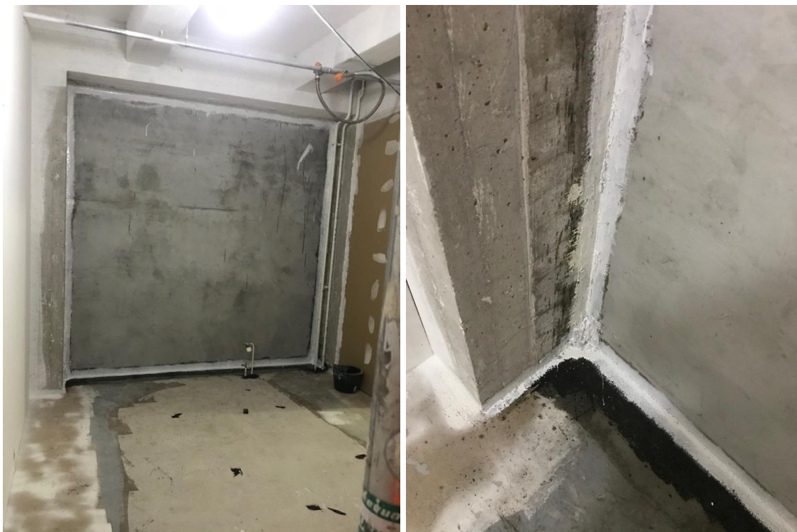
KUVAT 14 ja 15. Toisena kerroksena kapseloinnissa asennettiin valkoinen Hyytelö 2 -kerros. Hyytelökerroksia asennettiin kaksi, ensimmäinen valkoisella aineella ja toinen harmaalla aineella, jotta voidaan visuaalisesti varmistua aineen peittävän kapseloitavan alueen kokonaan.
