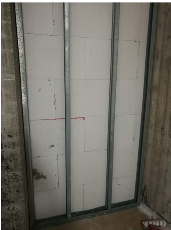
KUVA 16. Esimerkkikuva silikaattilevytyksen ja teräsrankarakenteen asennuksen dokumentaatiosta.
