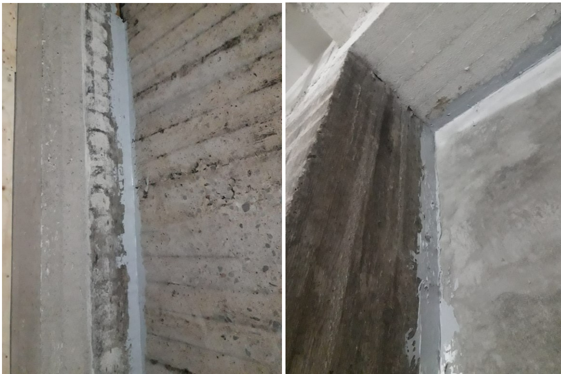
KUVAT 10 ja 11. Ennen kapselointia kaikki liittymäalueet käytiin läpi liimativistemassalla isoimpien rakojen tukkimiseksi.
