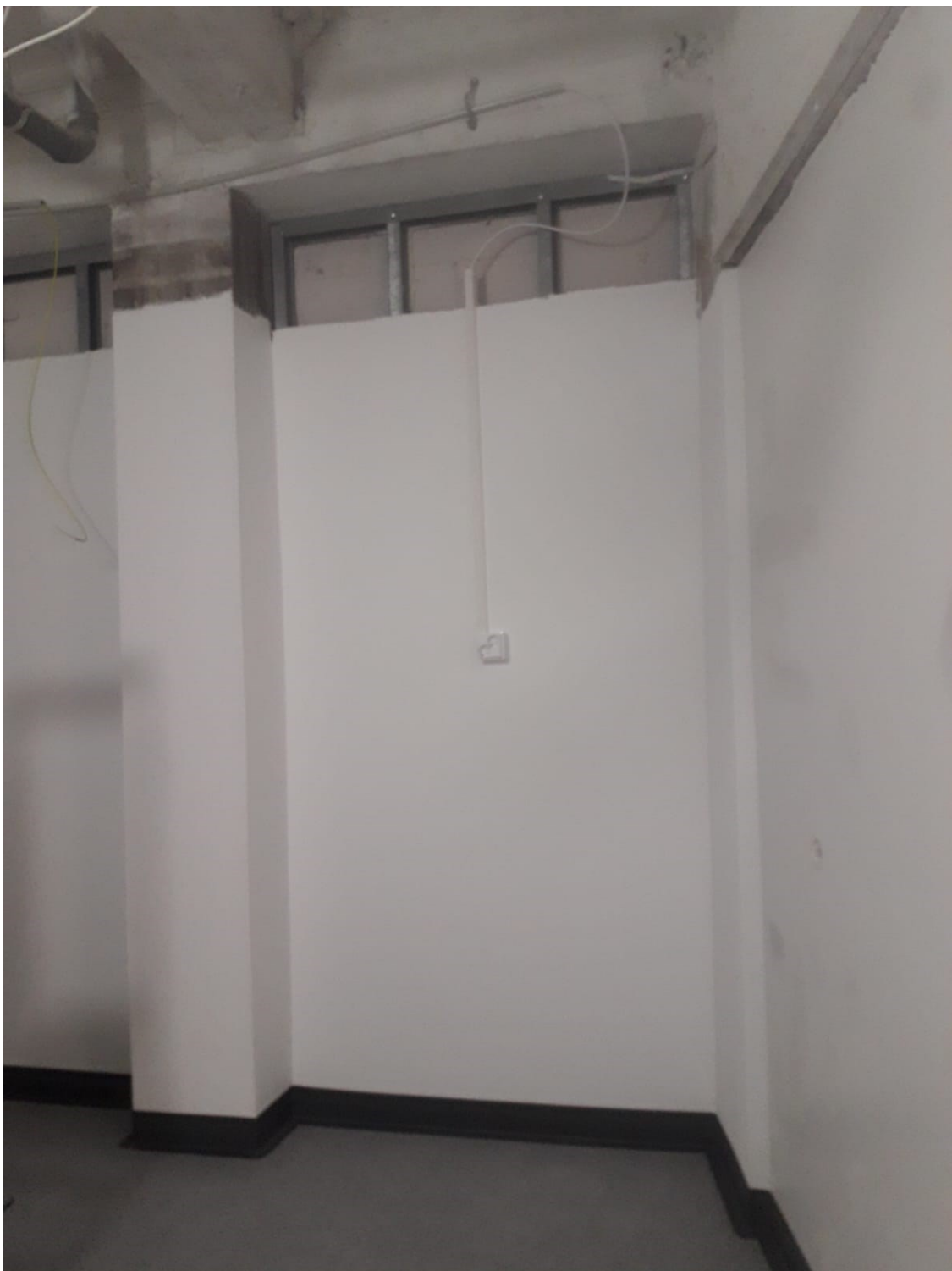
KUVA 21. Valmis seinärakenne ennen alakattojen asentamista. Luja-levytys tasoitettiin Weber V+ -hienotasoitteella tasoiteverkkoa hyödyntäen ja maalattiin Weber Silikaattimaalilla.
