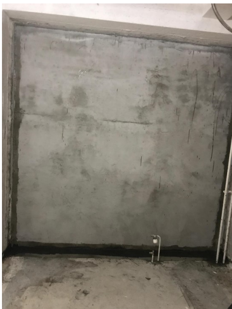
KUVAT 12 ja 13. Liittymäkohtiin asennettu ensimmäinen kerros kapselointiainetta (väritön TKR -pohjapinnoite). Kapselointikerrokset ulotettiin \geq 30 mm liittymäkohdista kumpaankin suuntaan.
