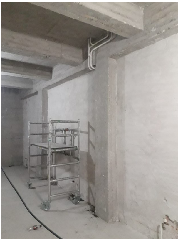
KUVA 2. Seinärakenne asbestipurkuna suoritettun hionnan jälkeen.
