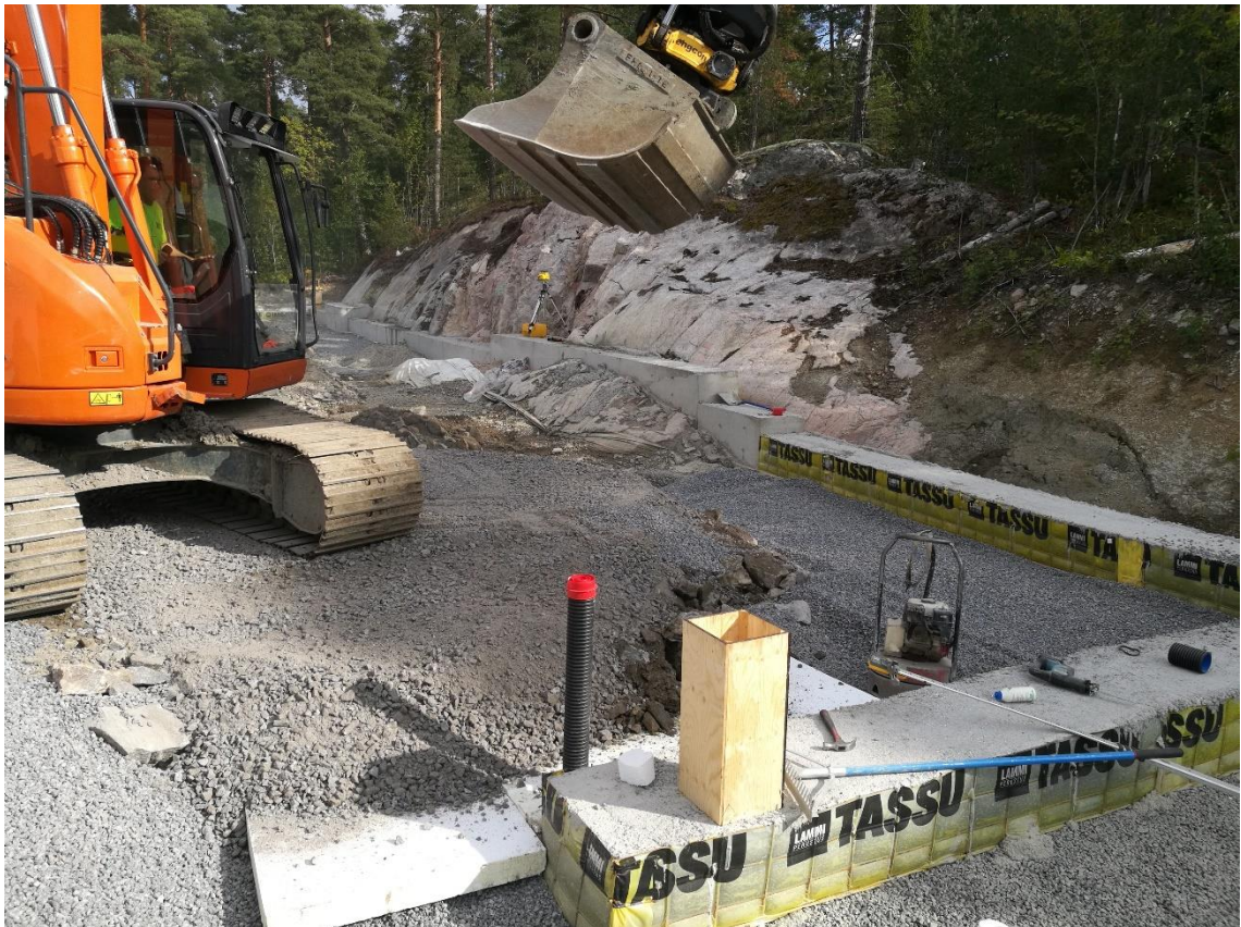
Kuva 3. Routalevyjen asennus ja välitäyttö.
