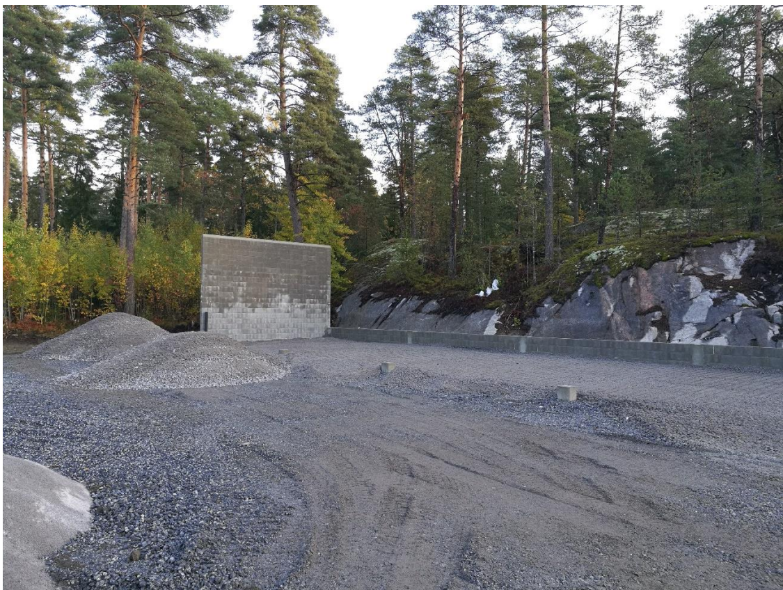
Kuva 5. Mursketäyttö valmiiseen korkoon.
