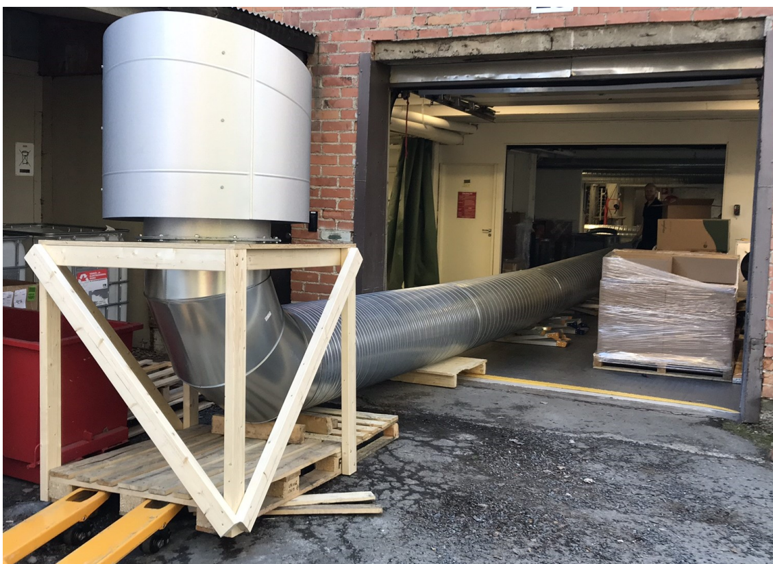
KUVA 7. Testiasetelma koottuna ulkoilmaan
