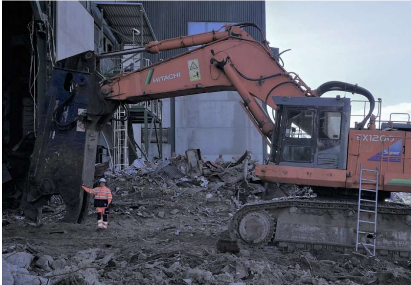
Kuva 8. Nokkaleikkuri suurten teräsrakenteiden paloitteluun (Hannele Nousiainen 2017)
