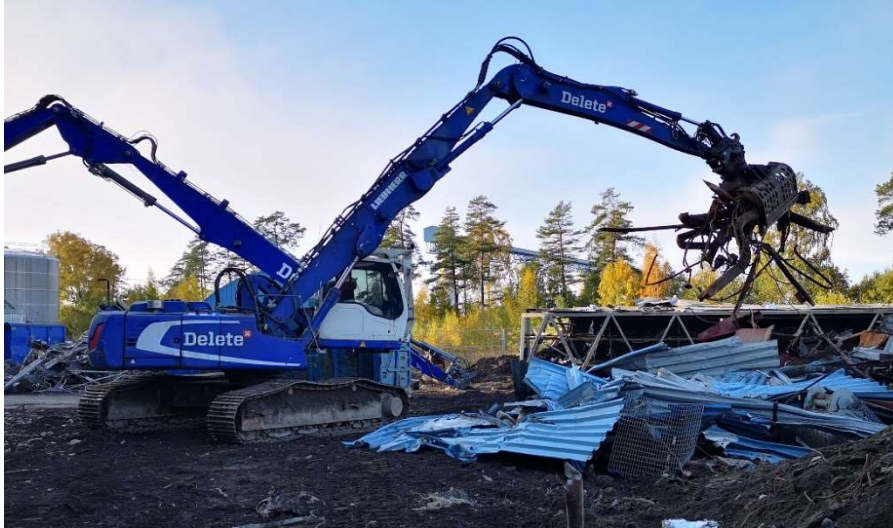
Kuva 10. Jätteen lajittelua materiaalinkäsittelykoneella (Hannele Nousiainen 2019)
