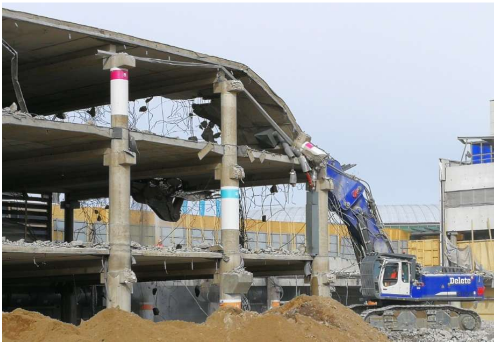
Kuva 3. Betonirakenteisen parkkitalon kokonaispurkua (Hannele Nousiainen 2019)
