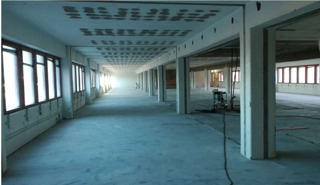
Kuva 2. Saneerauspurkutyö valmis uuden rakentamista varten (Hannele Nousiainen 2017)
