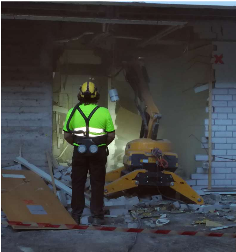
Kuva 1. Tiiliväliseinien purkua robotilla saneerauspurkukohteessa (Hannele Nousiainen 2017)
