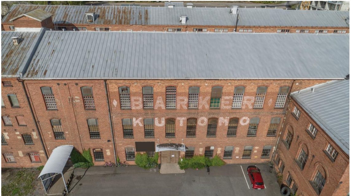
KUVA 11. Osan F4 julkisivu kaakkoon (Tietoa Oy 2018, muokattu).
