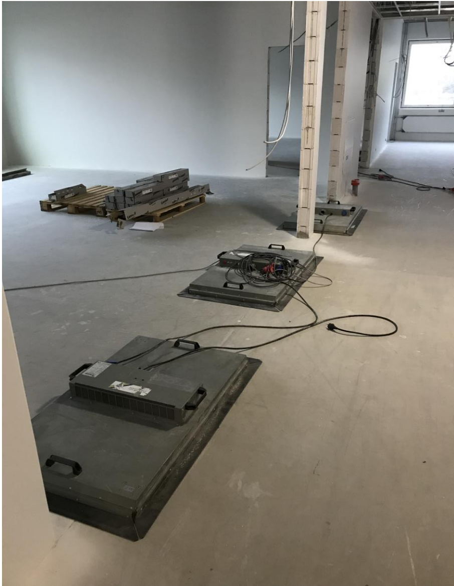
KUVA 13. Levykuivaimet on asetettu deltapalkkilinjalle tehostamaan palkiston kuivumista.
