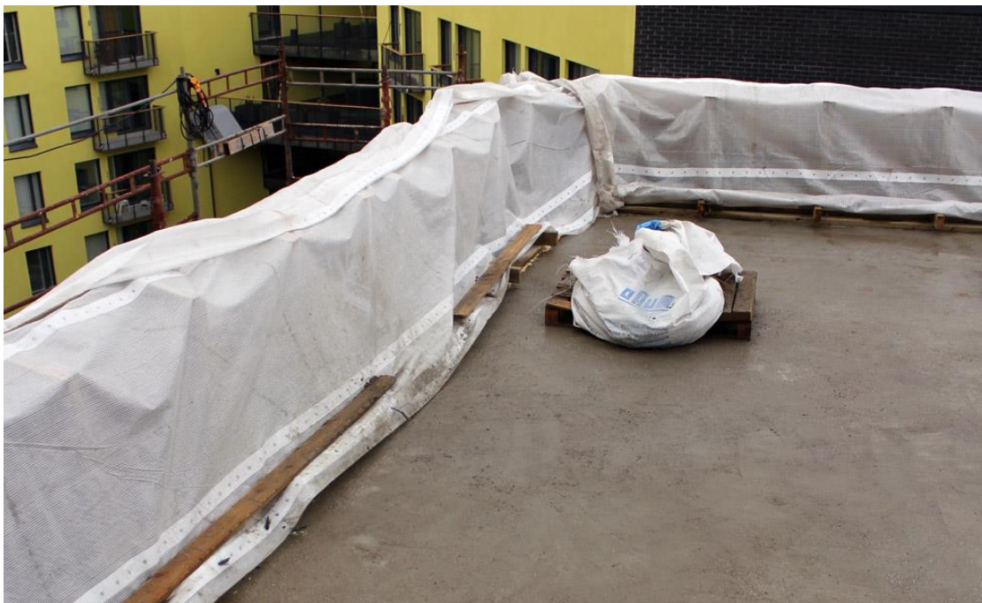
KUVA 7. Elementtien suojaus telinepeitteellä. (www.kosteudenhallinta.fi)
