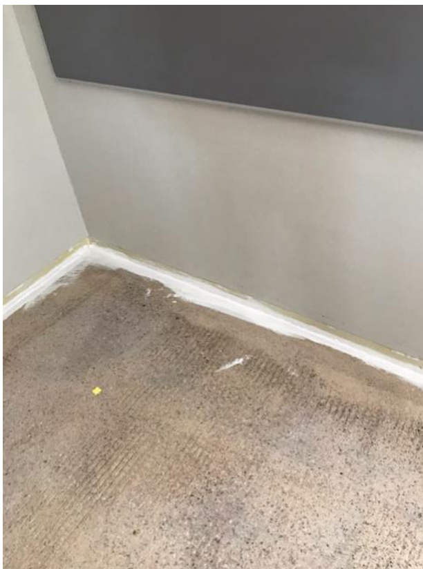
Kuva 9. Nurkkien kapseloinnit ja betonipinnan primerointi.
