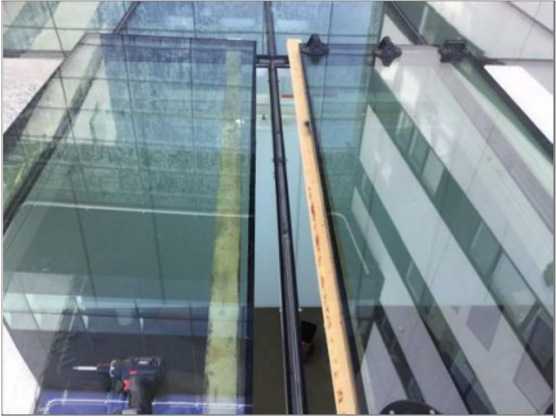
KUVA 18. Alumiinirunkoprofiilin molemmin puolin lasielementit nostettu sivuille.
