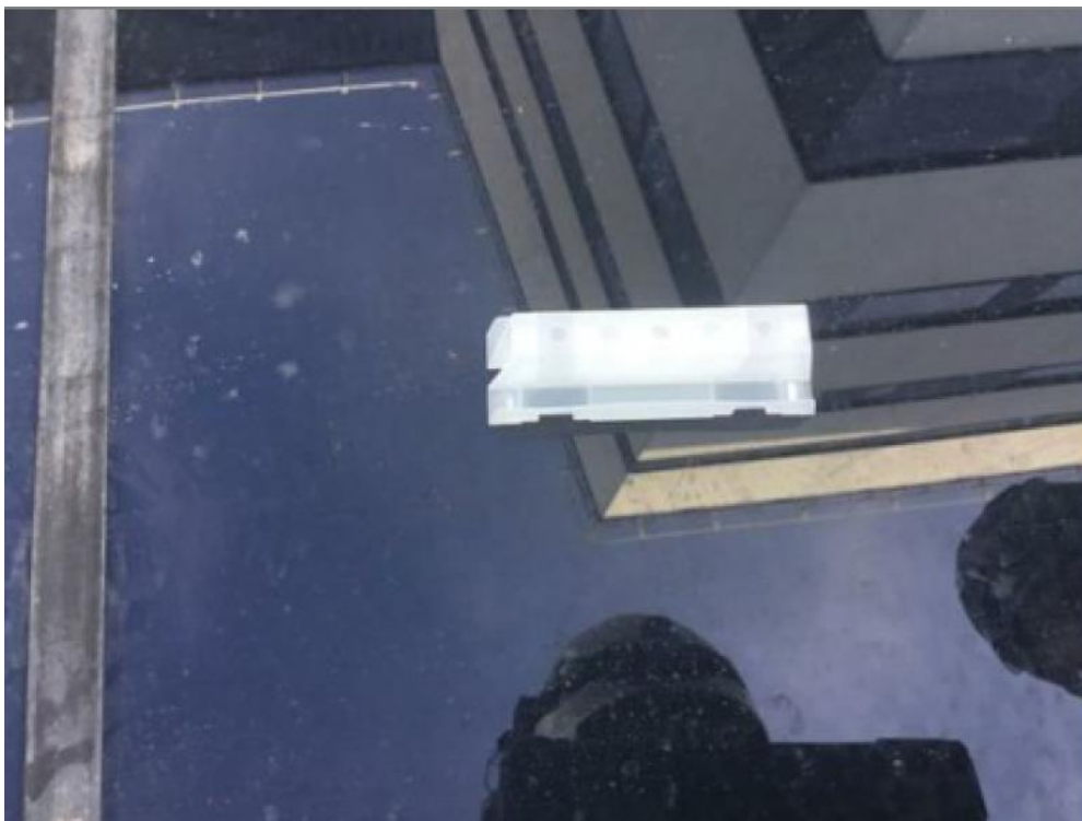
KUVA 20. Uusi jatkospala odottaa asennusta. Kuvasta näkyy jatkospalan täyttö- aukot.
