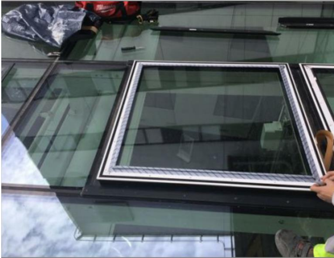
KUVA 15. Butyyliteipin lisäys savunpoistoluukun päälipellin alle.
