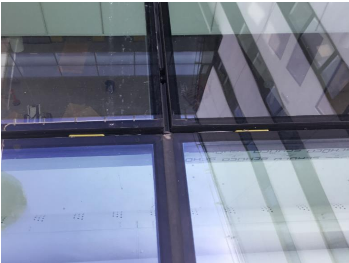
KUVA 3. Lasielementin keltaiset lasikiilat ja mustat asennuspalat asennettuna.
