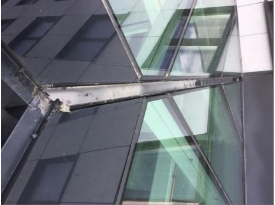
KUVA 17. Uusi aluspelti asennettu. Ylhäältäpäin laitettu jo tulevan päälipellin alustukipalatkin.
