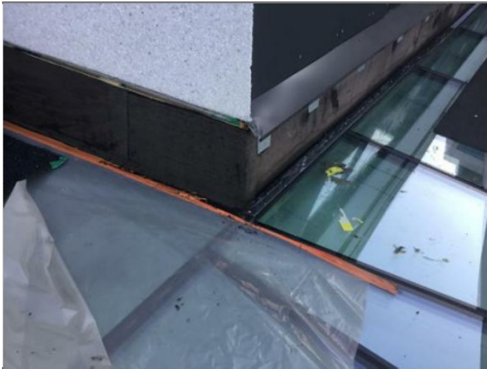
KUVA 11. Naamapelti poistettu ulkonurkan kohdalta, jonka takana huopanosto.
