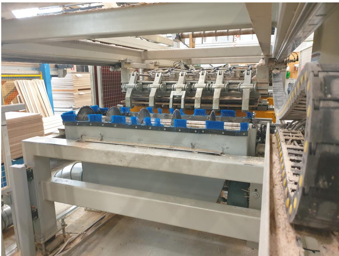
KUVA 12. Liimattu levy odottamassa jakosahan käynnistystä (Kuva: Aleksi Kajander)
