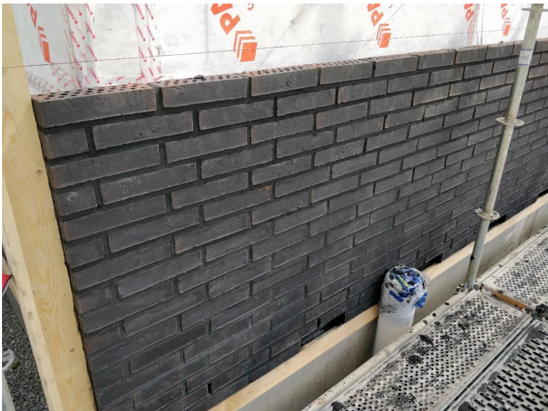
Kuva 1. Julkisivumuuraustyötä edeltävät työt olivat valmiit ja muuraus aloitettu.
