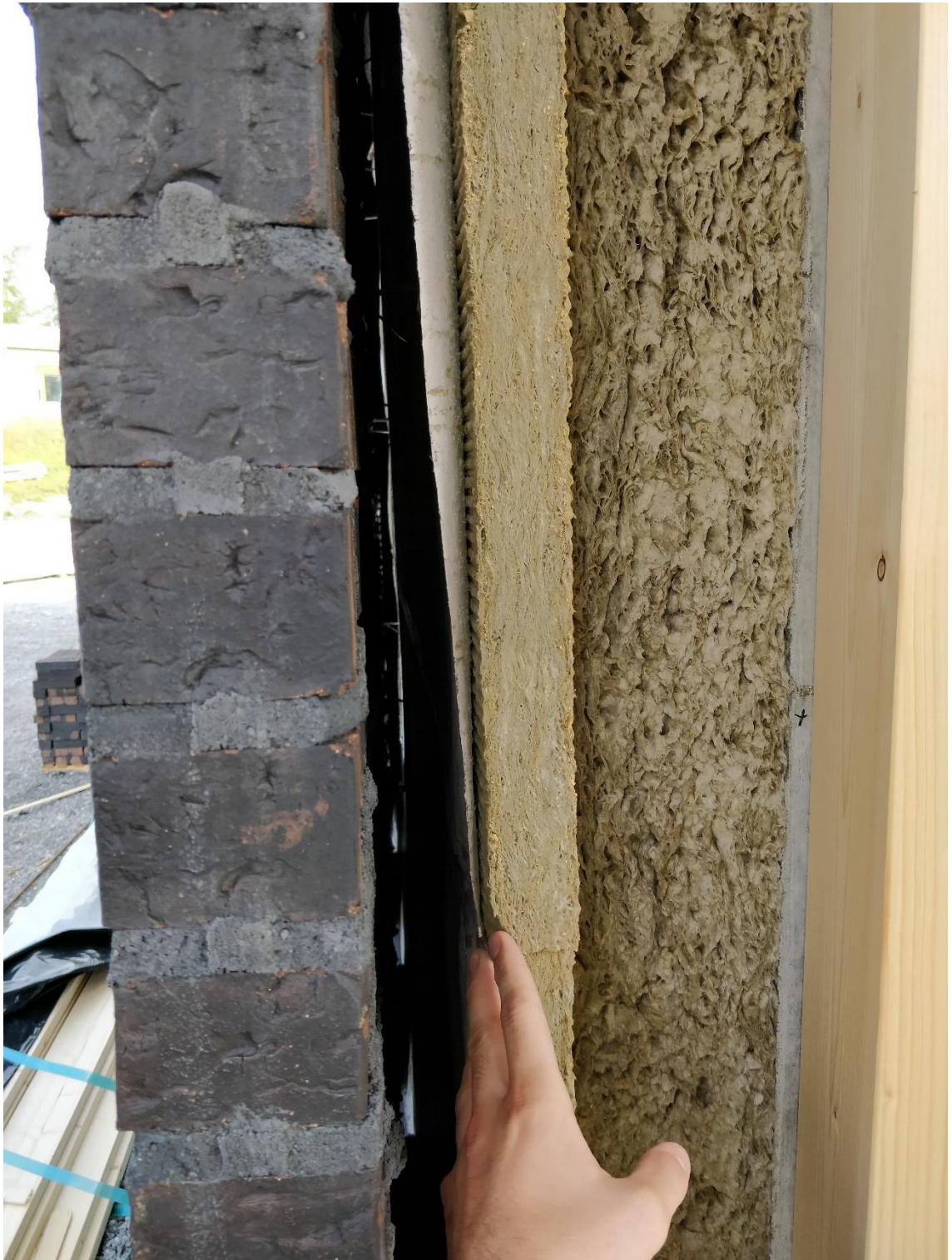
Kuva 4. Muurauksen ja villoituksen tuuletusväli oli pidettävä riittävänä.
