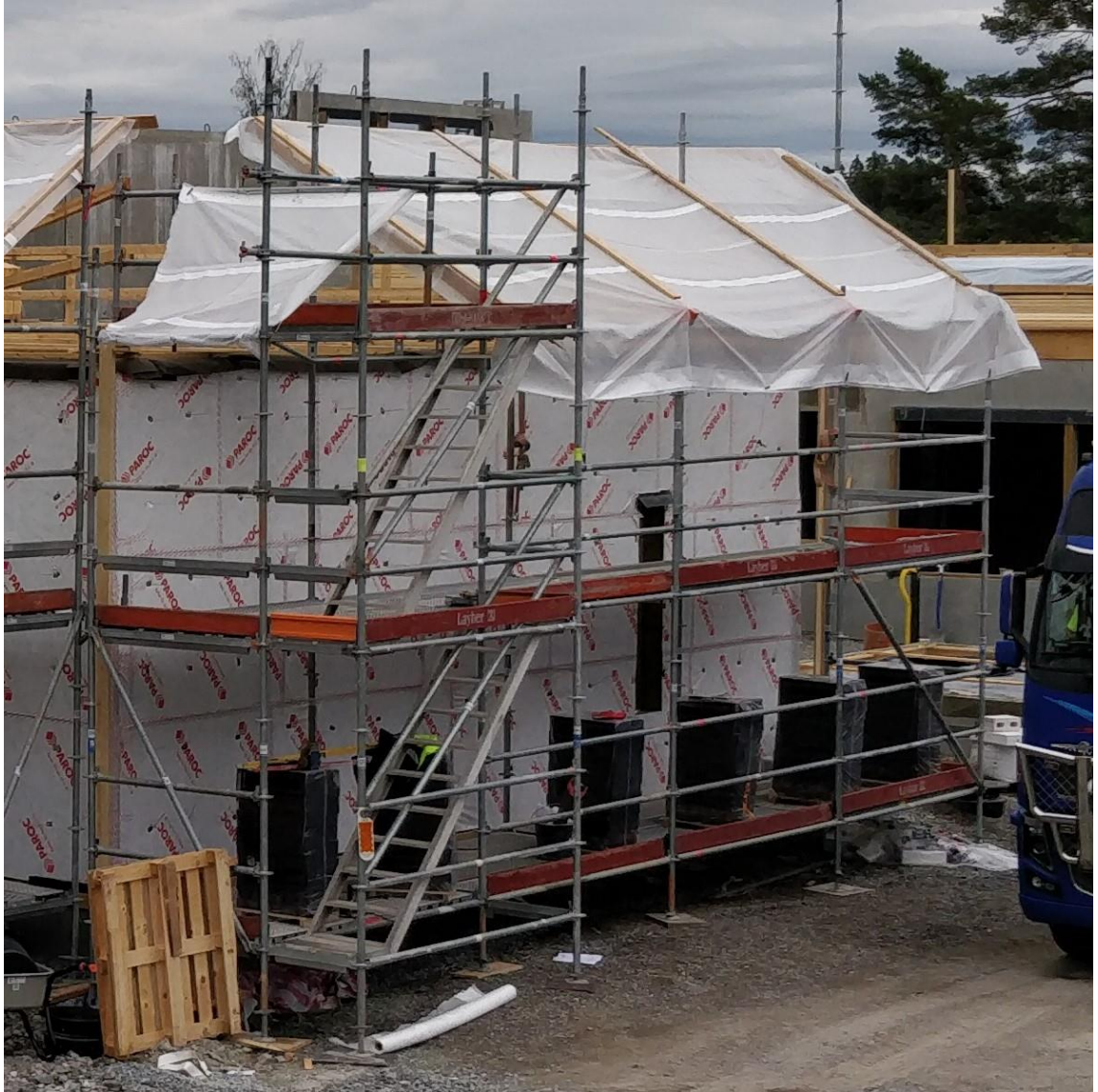
Kuva 5. Muuraustelineiden yläpään kevytsuojapeitteestä tehtiin katos.
