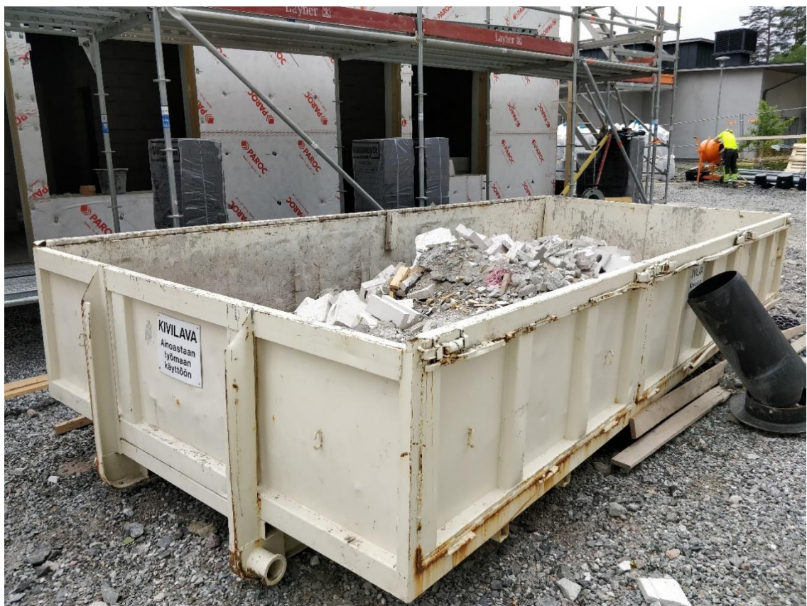
Kuva 2. Kuvassa on jätelava, joka on tarkoitettu kivijätteelle.
