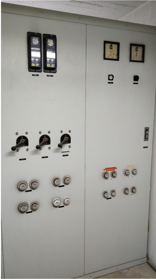
Kuvio 5. Tasasähkökeskus 56SY02 käyttöpuolelta
