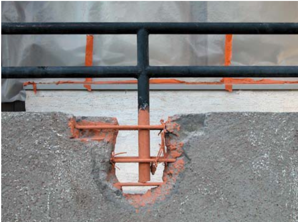
Kuva 15. Esillepiikattuja ja suojakäsiteltyjä raudoituksia Runkolassa (5.)
