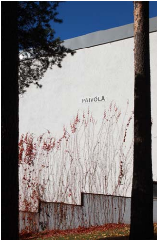
Kuva 13. Päivölään tehdyt korotetut räystäslisät jotka muuttavat talon julkisivun ilmettä alkuperäisestä (4.)
