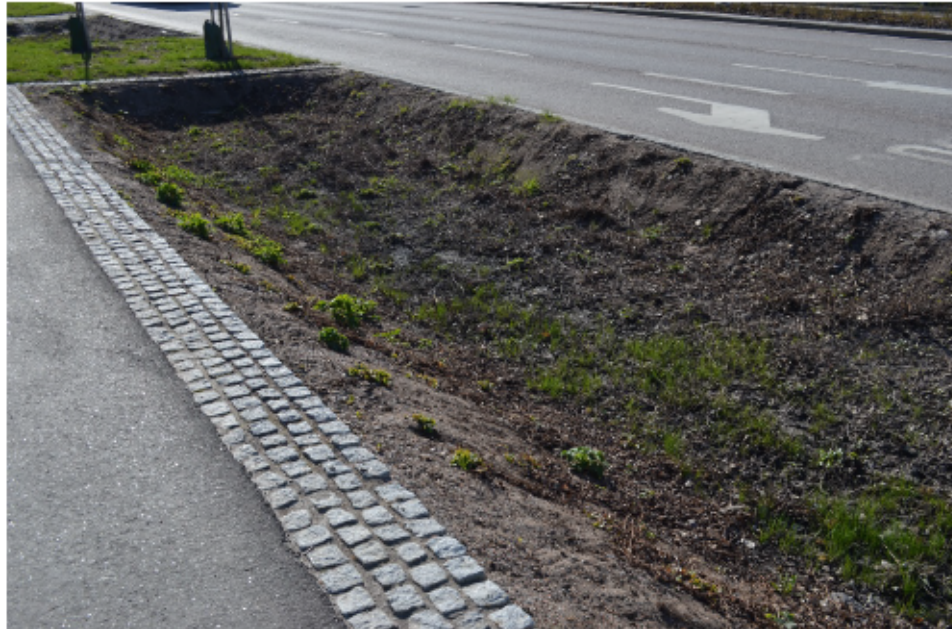
Kuva 5. Biosuodatusaltaan yhtenä huleveden hallinnan keinona on huleveden puhdistaminen. Tässä biosuodatusaltaassa on testattu biohiilen ominaisuuksia hulevesien puhdistamisessa.
