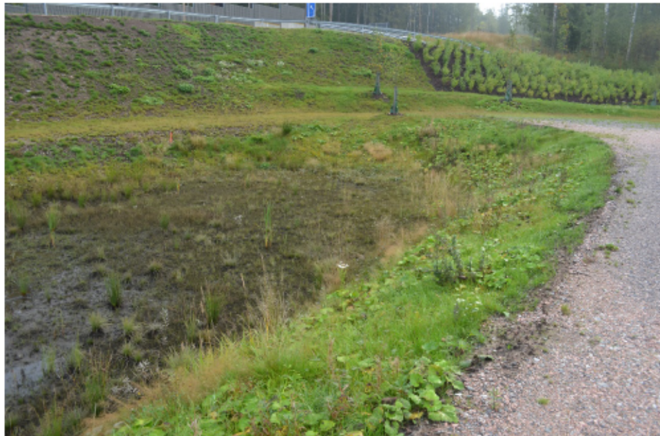
Kuva 3. Kaksi isoa hulevesiallasta sijaitsevat vilkkaan tien varressa. Yhdessä altaat puhdistavat, viivyttävät ja varastoivat hulevettä. Kuvassa näkyvä osa toisen altaan päädystä on tarkoitettu kertyvän huleveden varastoimiseen.
