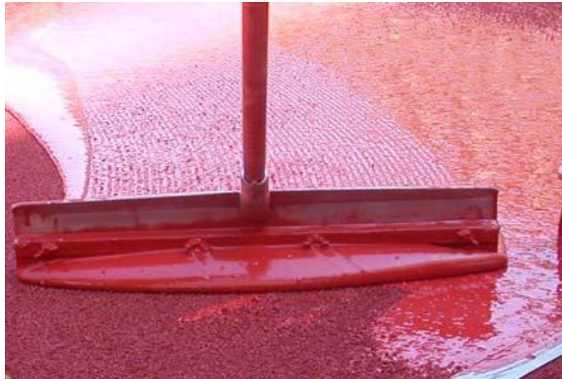
Kuva 11. Polyuretaaniliuoksen levitystä, ennen EPDM-rouheen sirottelua.
