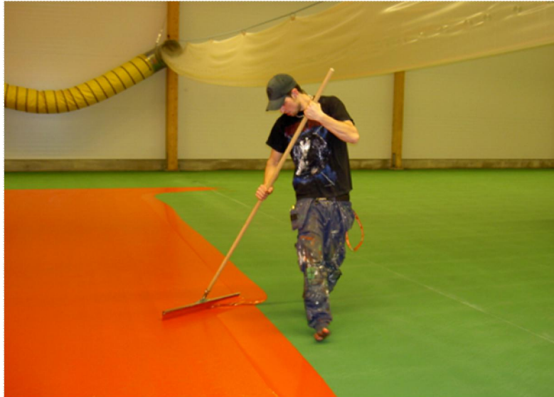
Kuva 23. Conipur-pinnoitteen levitystä.
