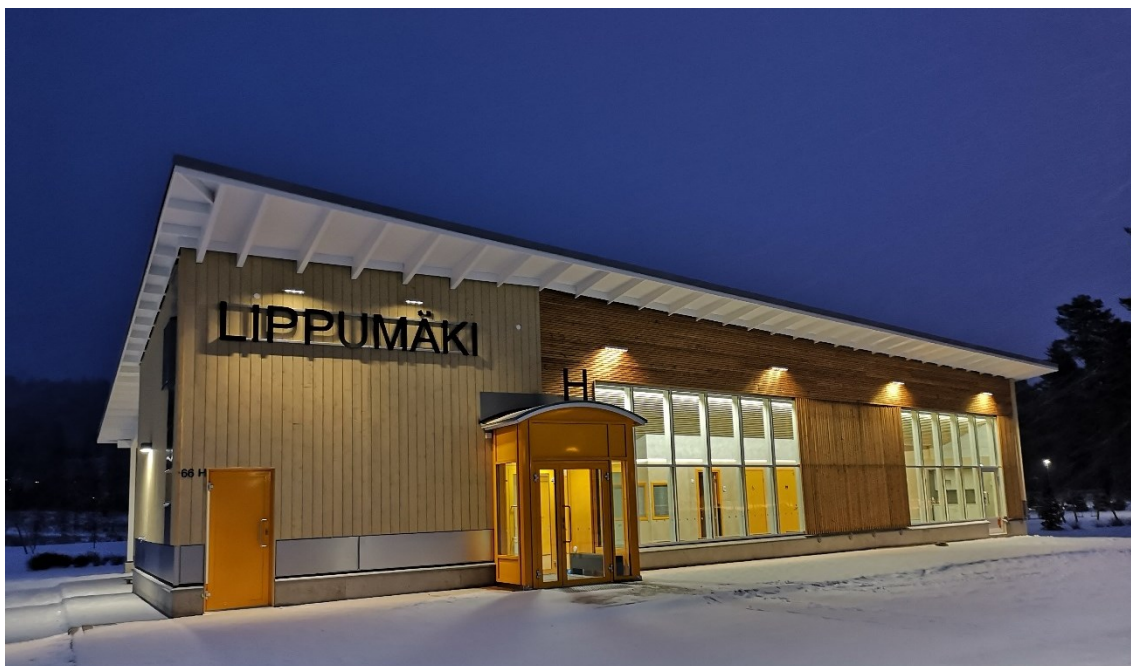
Kuva 22 Valokuva vastavalmistuneesta Lippumäen huoltorakennuksesta (Kuopion Tilakeskus: Tavi 2019-11-02.)
