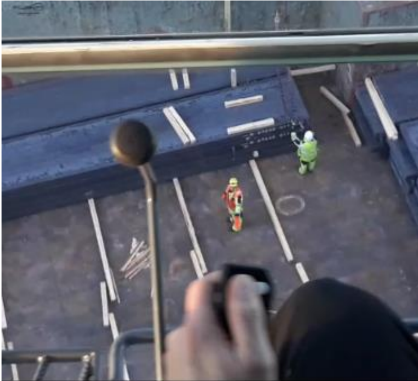
KUVA 9. Merkkimies viittaa kädellä suoraan kohti tulevan noston sijoituspaikkaa
