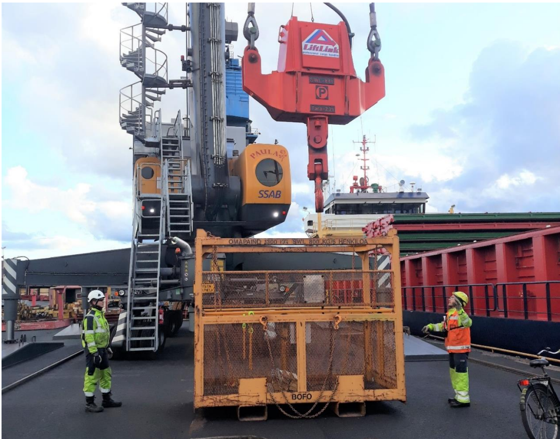
KUVA 4. Huomioliivinen kenttäturva-ahtaaja näyttämässä merkkiä nosturinkuljettajalle ja kenttäahtaaja odottamassa henkilönostokorin vieressä
