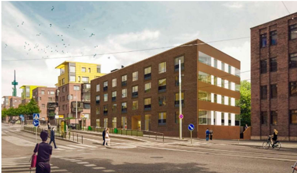
Kuva 8. Havainnekuva Helsingin Villiviinistä etelästä Aleksis Kiven kadulta päin kuvattuna. (YIT Rakennus Oy 2016)
