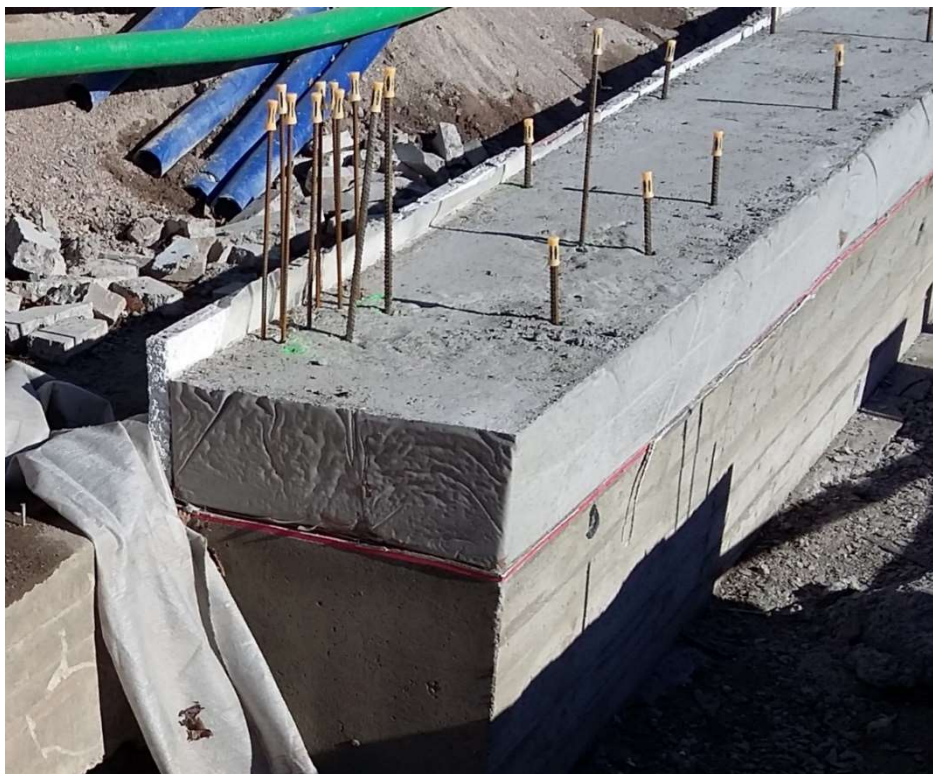
Kuva 4. Helsingin Villiviinissä paaluanturoiden ja vasta-anturoiden eristämiseen käytetään Sylomer-eristimiä. (Savolainen 2016)
