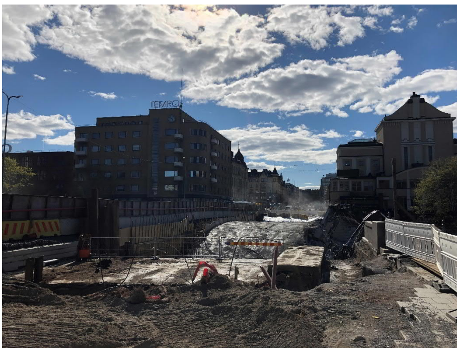
KUVA 3. Hämeensillan uusiminen Tampereen ydinkeskustassa (Nurmiranta 2019)
