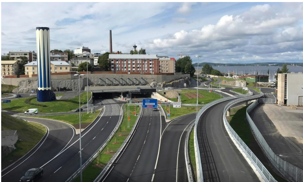
KUVA 1. Tampereen rantatunnelin Naistenlahden pää (Nurmiranta 2017)
