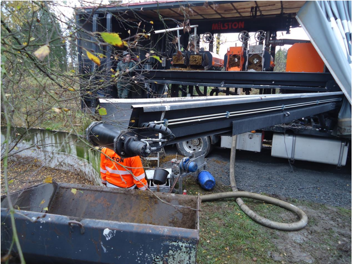
Kuva 4. Milston E2 -separaattorit toiminnassa kuorma-auton lavalla.
