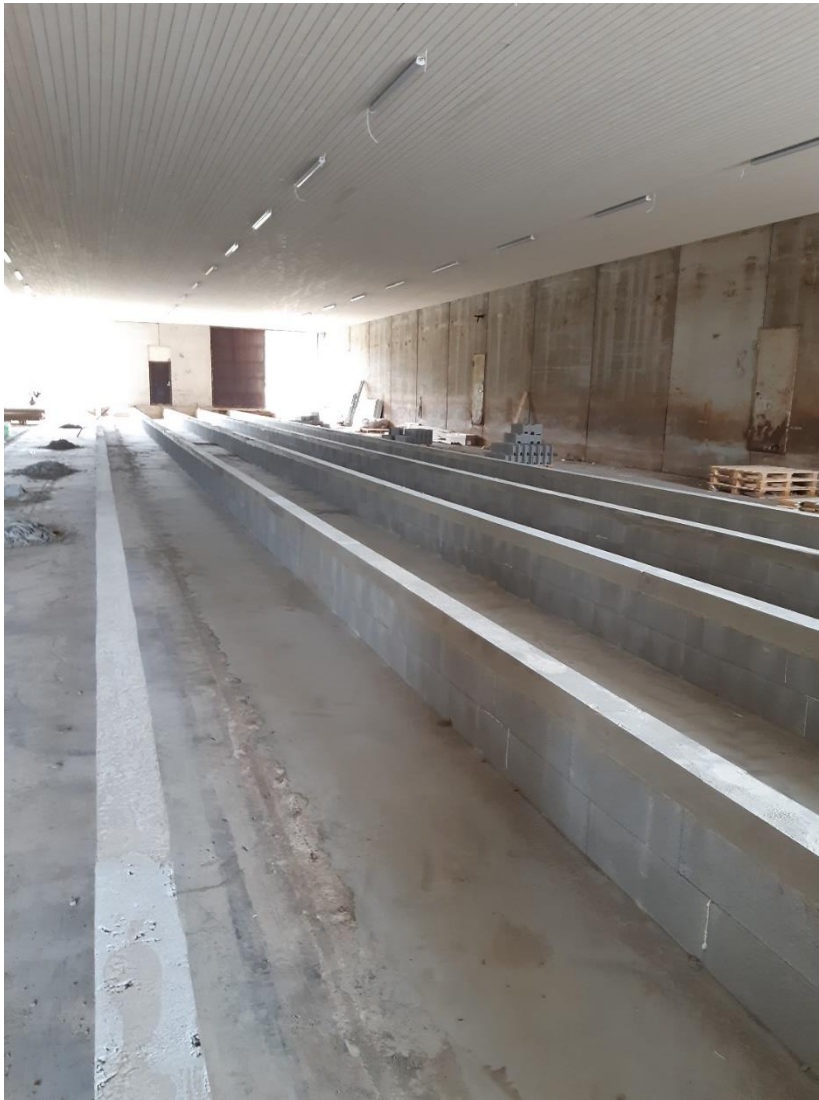
Kuva 21. Kuva. Lantakäytävät, joiden päälle asennetaan betoniritilät. (Lehtinen, 2019).
