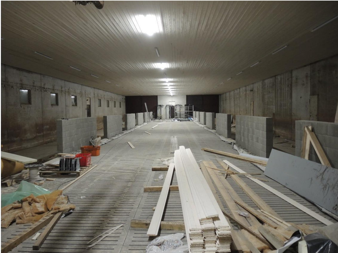
Kuva 19. Osasto rakennusvaiheessa. Päädyssä lantaraappojen ajokoneistot, (Lehtinen, 2019).
