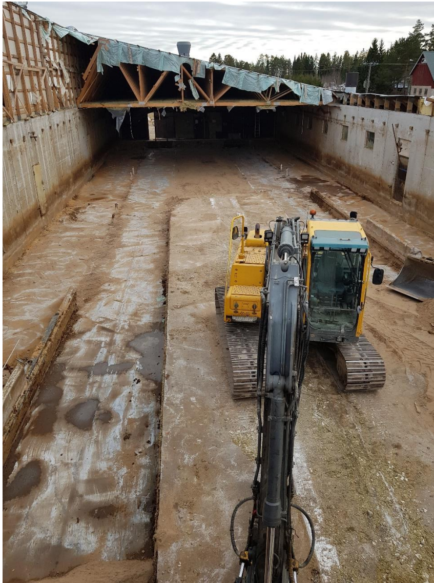
Kuva 5. Osaston lattian purkamista, (Lehtinen, 2019).
