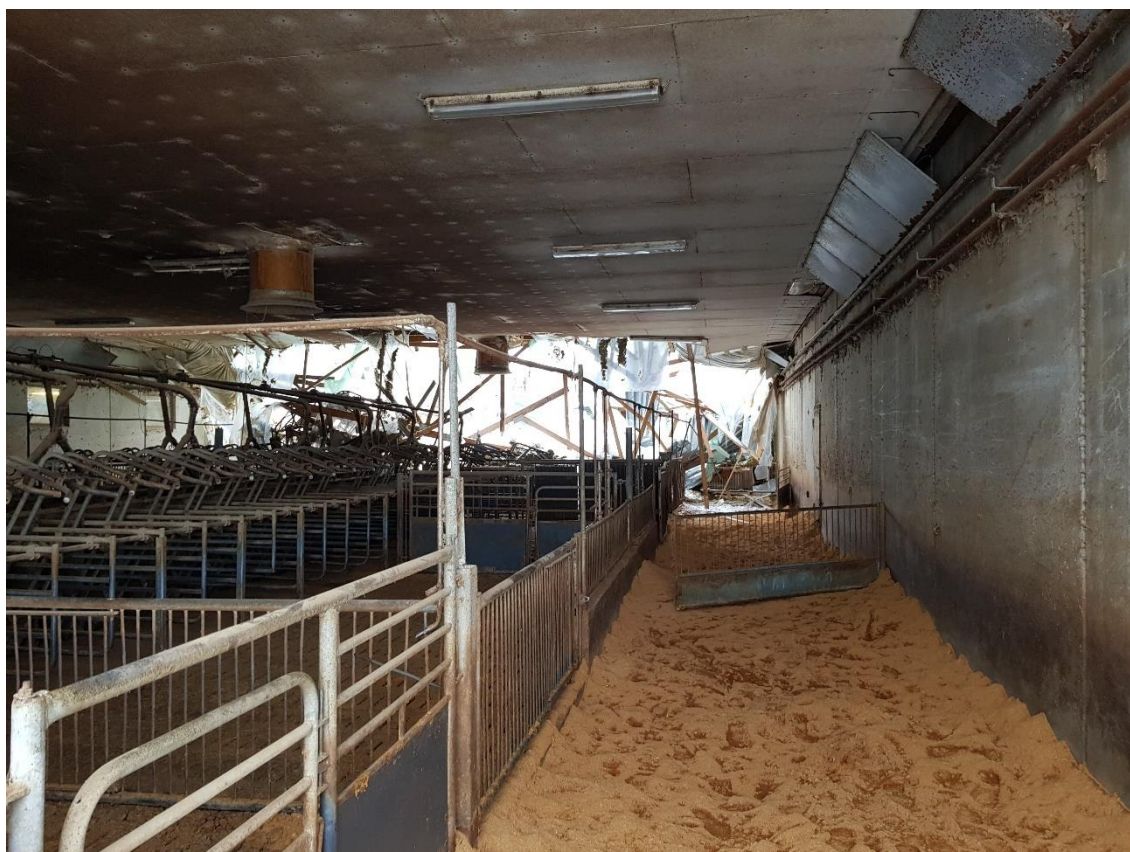
Kuva 4. Porsasmyllyn romahdustyömaan eteläpuolta, (Lehtinen, 2019).
