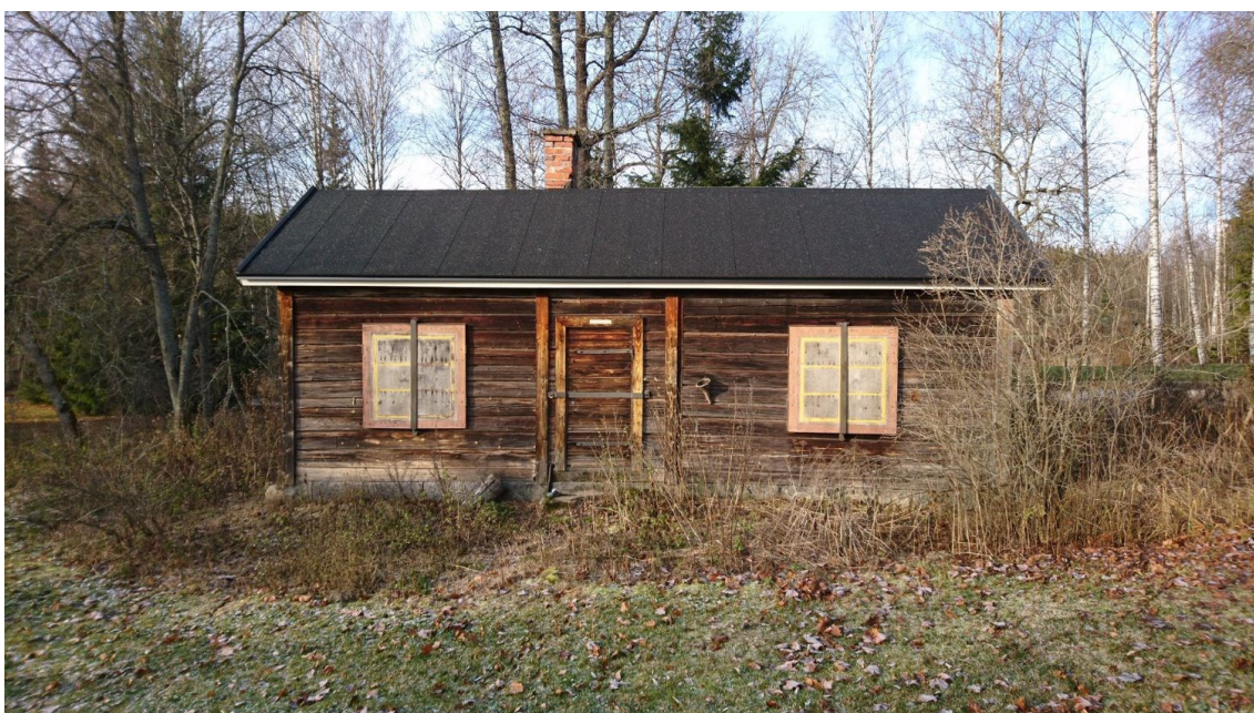
Kuva 4. Kasvillisuus on ympäröinyt saunarakennuksen. (Teresa Jalander)
