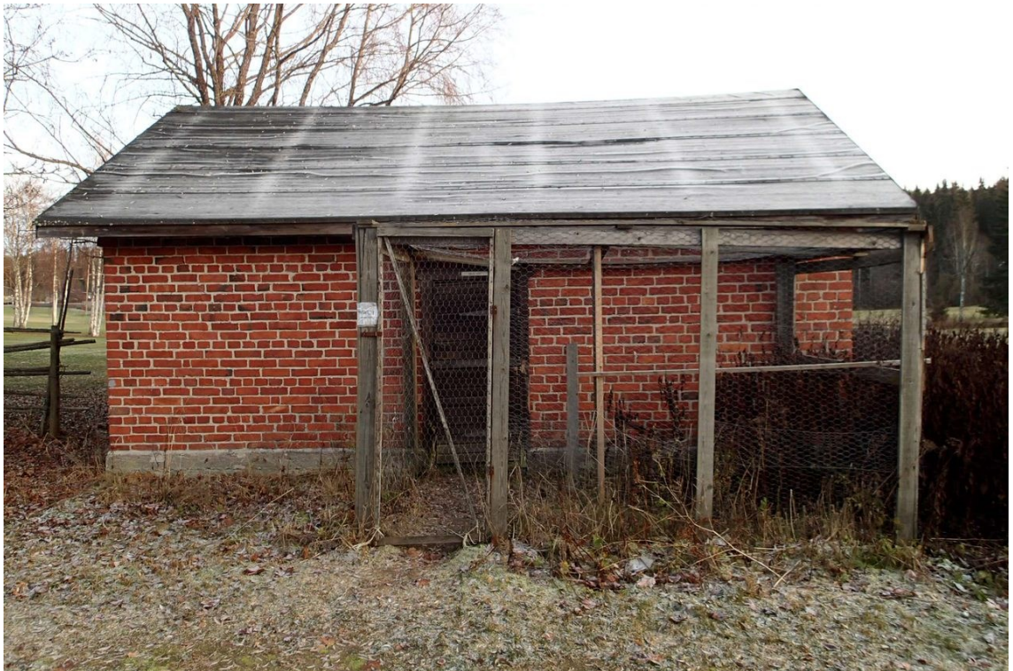
Ulkopuoliset rakenteet sekä kasvillisuus hidastavat kuivumista.
