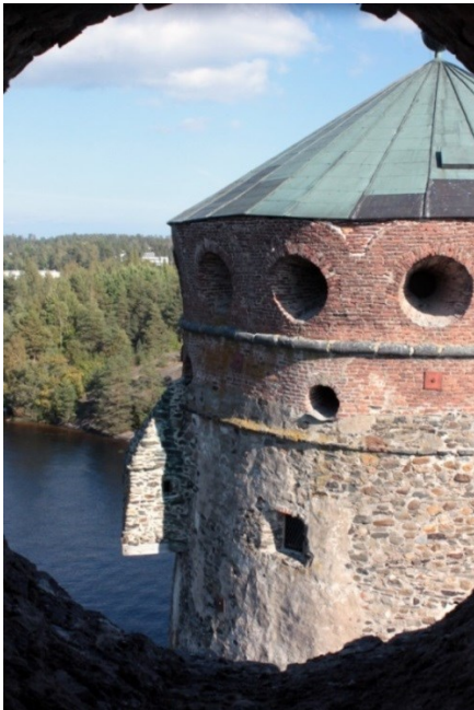
Kuva 2. Olavinlinnan pyöreän tykkitornin seinästä erottuu hyvin käymäläuloke. (Hautamäki, 2014–2015)
