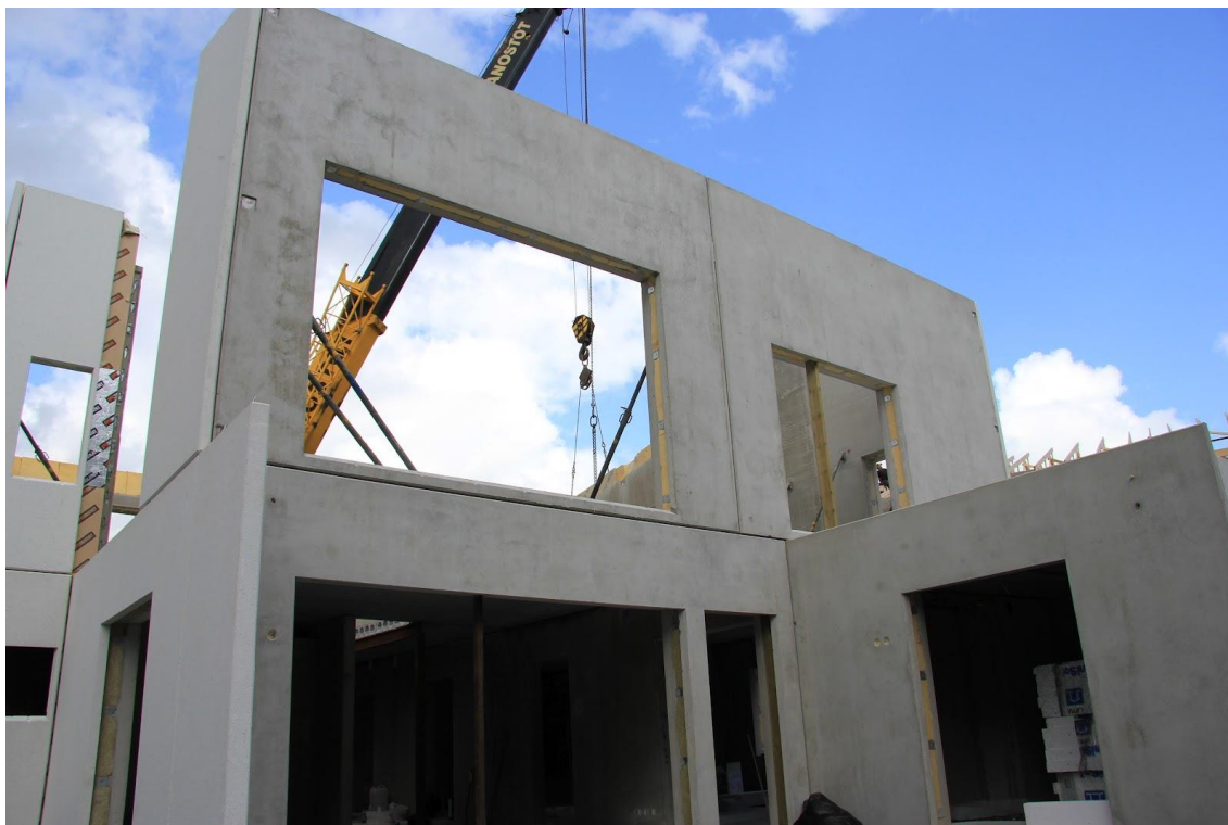
KUVA 4. Erään rakennusyrityksen työmaa. (5)
