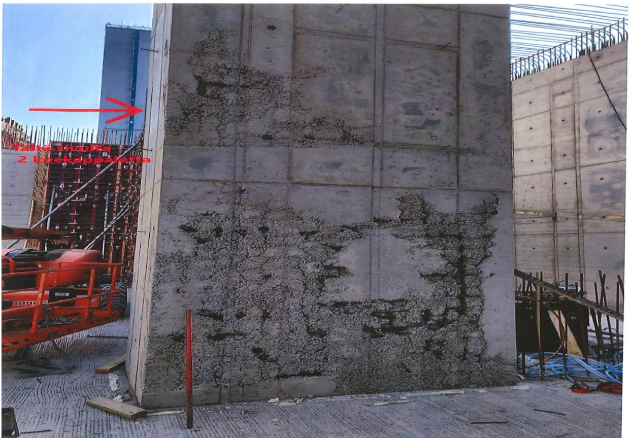
KUVA 5. Erään rakennusyrityksen työmaa (6.)
