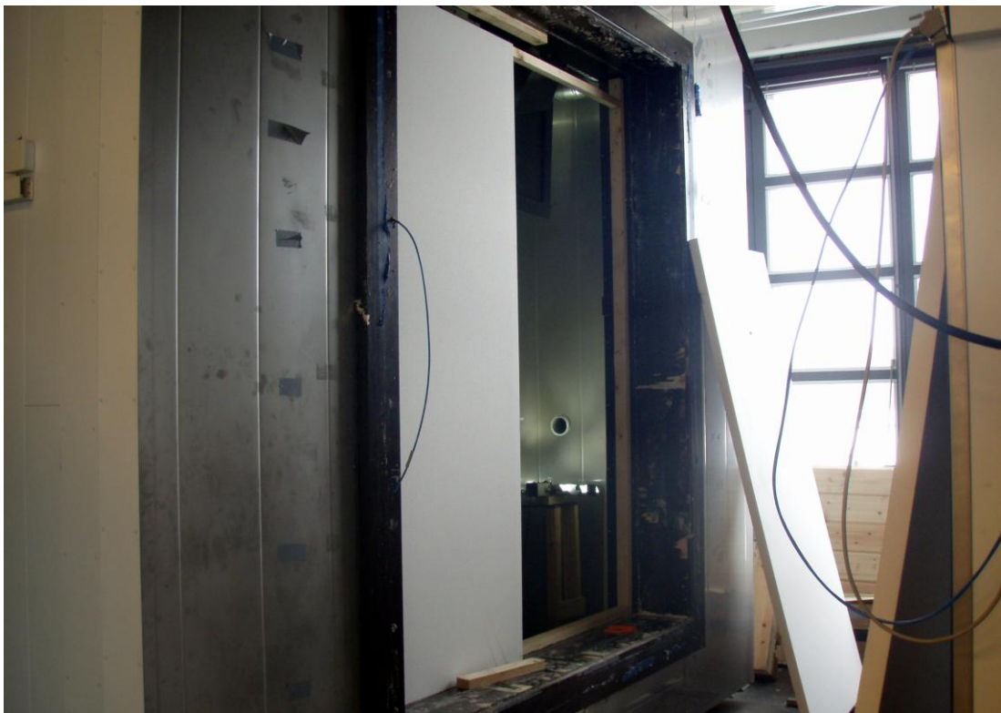
KUVA 3. Keskeneräinen seinärakenne olosuhdehuoneessa
