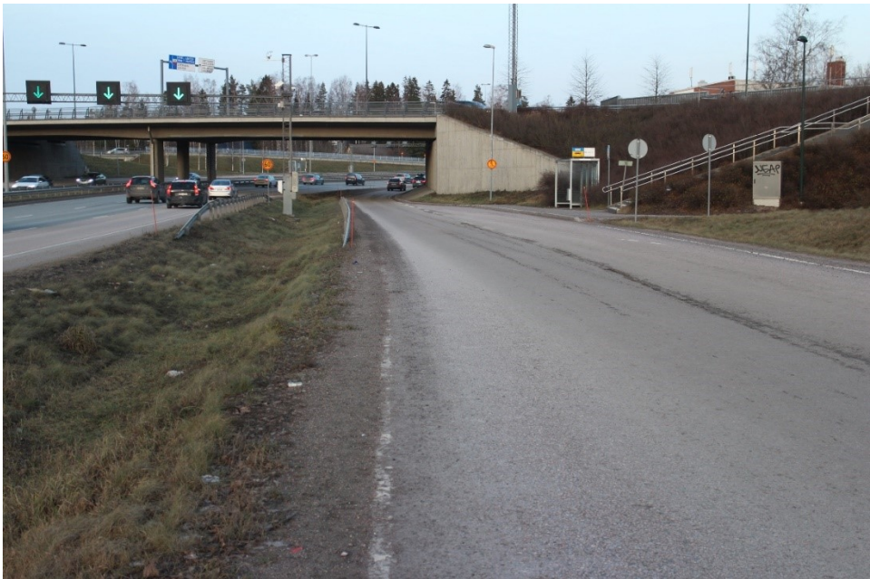
Kuva 13. Mestarinsillan erillispysäkki on yhdistetyllä linja-auto- ja liittymisrampilla Mt 101:llä, Kehä I idän suuntaan. Pysäkki sijaitsee Mestarinsolmun eritasoliittymässä Espoon Mäkkylässä. Kuva otettu joulukuussa 2019. Kuva: Marko Suni
