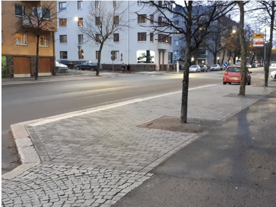
Kuva 5. Sipoonkadun (pohjoispuoleinen) pysäkkiniemeke Aleksis Kiven kadulla, Helsingissä joulukuussa 2019. Katso lisätietoja kuva 6. Kuva: Marko Suni
