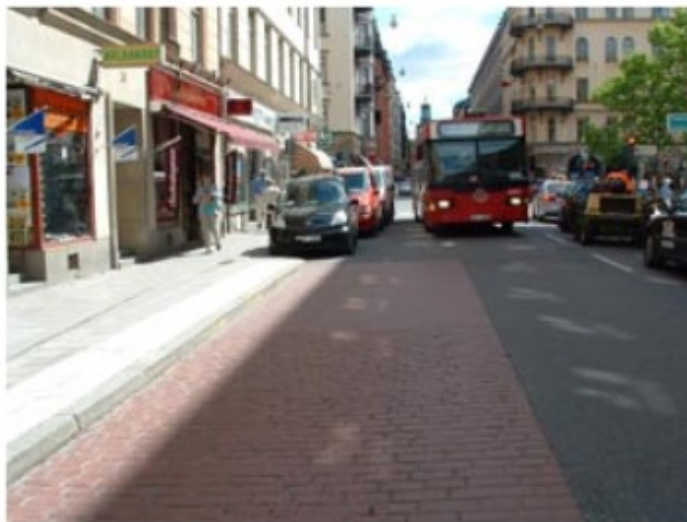
Kuva 23. Kapea pysäkkiniemeke on pysäköinnin reunalinjasta noin metrin levyinen uloke, jonka lisäksi pysäkin seisontatilassa on käytetty huomiovärinä punaista kiveystä, jolla halutaan vähentää väärin-pysäköintiä. (Vägverket, n.d., s. 13).
