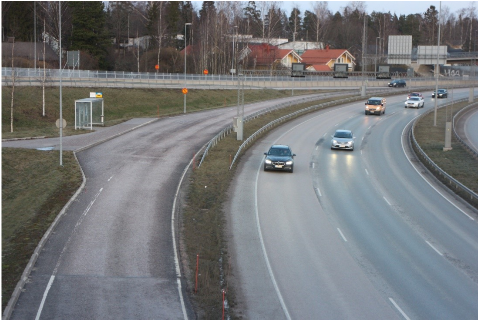
Kuva 12. Mestarinsillan erillispysäkki linja-autorampilla, Mt 101:llä, Kehä I lännen suuntaan. Pysäkki sijaitsee Mestarinsolmun eritasoliittymässä Espoon Vallikalliassa. Kuva otettu joulukuussa 2019. Kuva: Marko Suni
